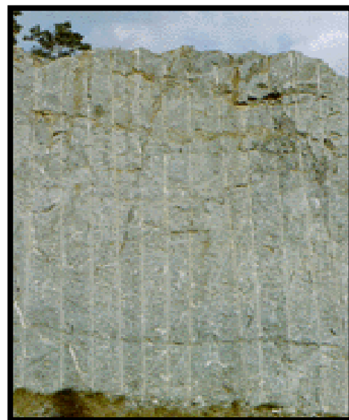
Слика 6. Класична комбинирана метода на контурни минирања (пригушено минирање - предминирање - рамно минирање) во две фази при пробивање на усек, изглед на косина по извршено минирање (десно), 1,2,3,... редослед на иницирање
