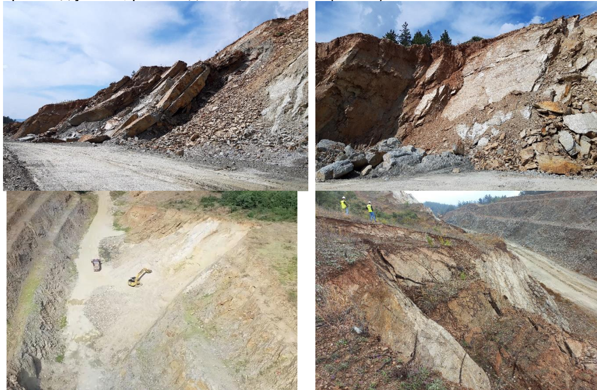
Слика 2. Состојба на усекот април 2022 год, каде јасно се гледаат клизни рамнини со поголеми димензии
