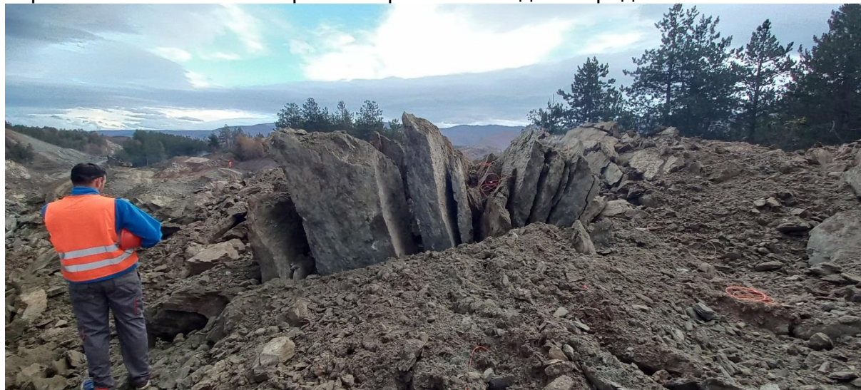
Слика 5. Одвоени поголеми нестабилни блокови од посвежи шкрилци, десна страна на усекот
