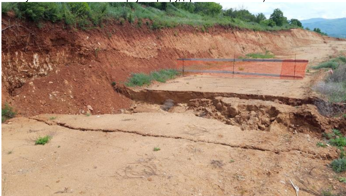
Слика 5. Пропаѓање на траса на патот на km 14+750 регистрирано во 2022г
