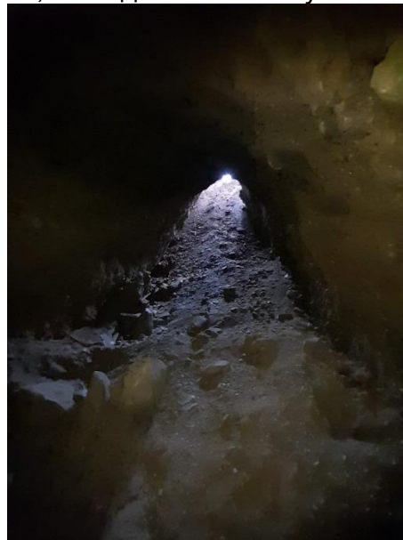
Слика 3. Влез во извозен нископ 2, изведен во збиени заглинети чакали
