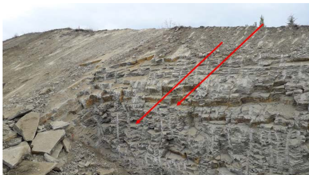
Слика 5. Наизменично сменување на цврсти услоени и тенкоплочести карпи, црвена стрелка – насока на можно лизгање на косината на Клучка Штип Југ, Експресен пат А4, делница Штип-Радовиш.
