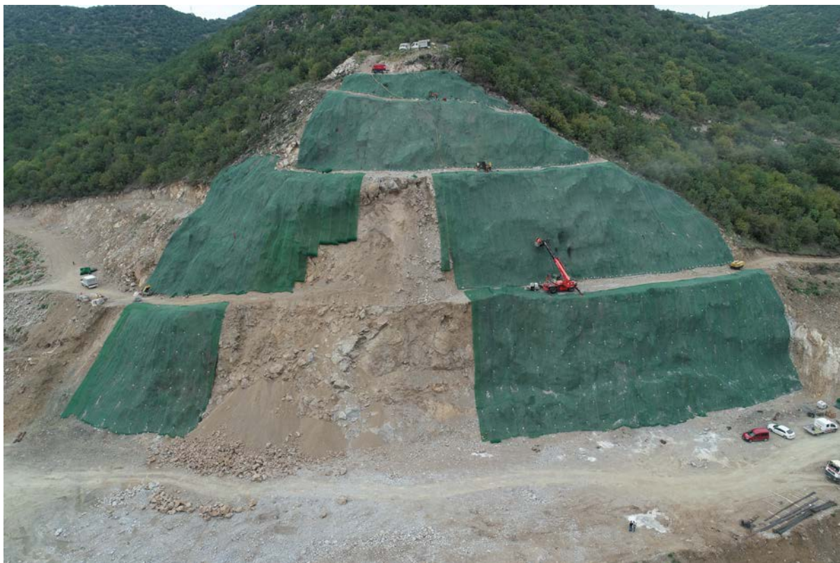
Слика 4. Изглед на усекот на км 23+200 – 23+400 во фаза на изведба на заштитата.
