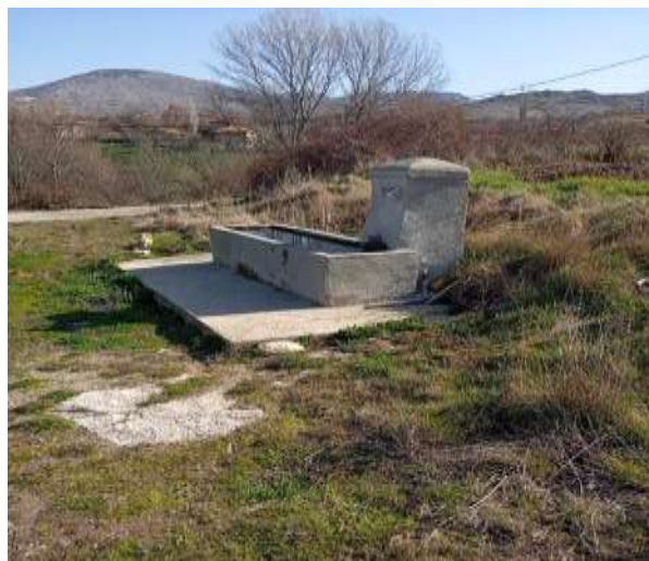
Слика 6. С. Лениште чешмата Ивкоец селска чешма средсело изградена 1948 од партизаните и реновирана е 1968 г. Извор: Фото: Цане Котески, 13.03.2026, 10:15ч.
