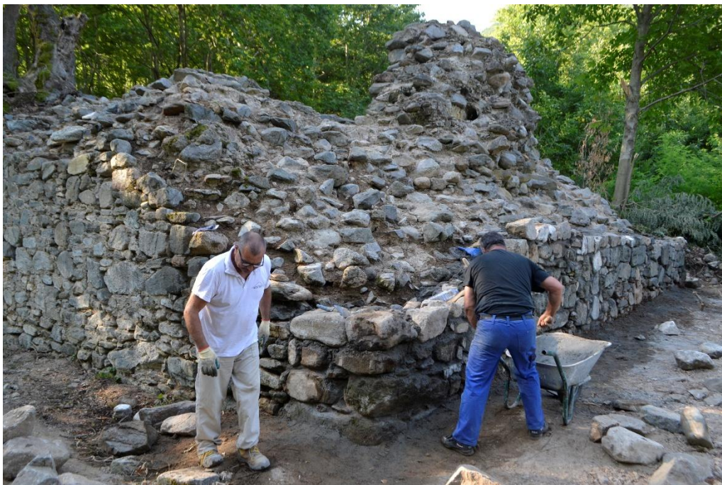
Сл.11 Во тек на конзервација и реставрација во западниот надворешен агол
