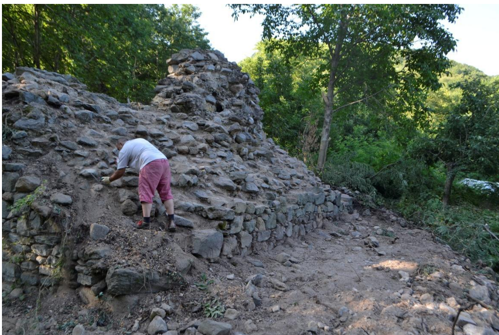
Сл.5 Северозападен ѕид во текот на чистењето
