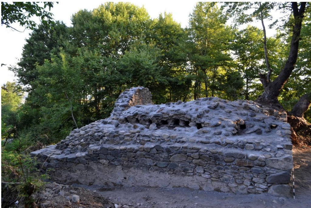
Сл.16 Југозападен сид по извршената конзервација и реставрација
