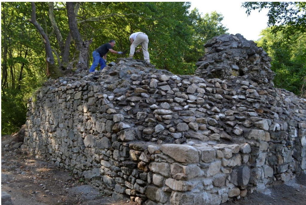
Сл.14 Во тек на конзервација и реставрација на јадрото на североисточниот сид
