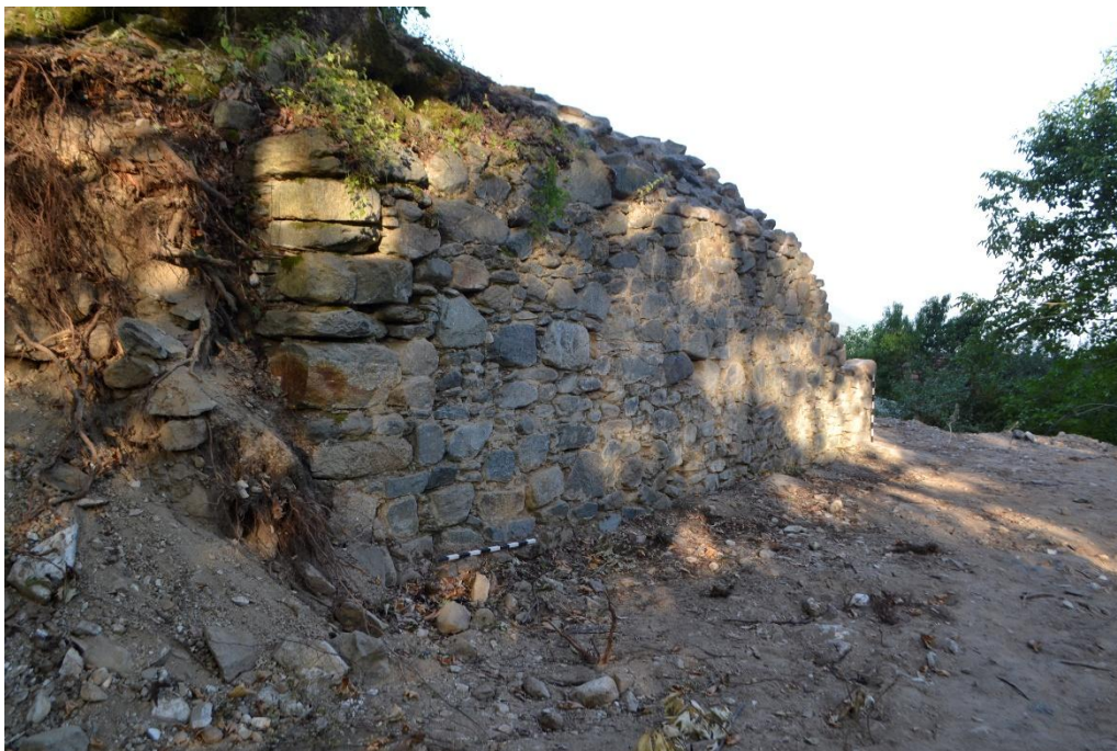
Сл.18 Североисточен сид по извршената конзервација и реставрација
