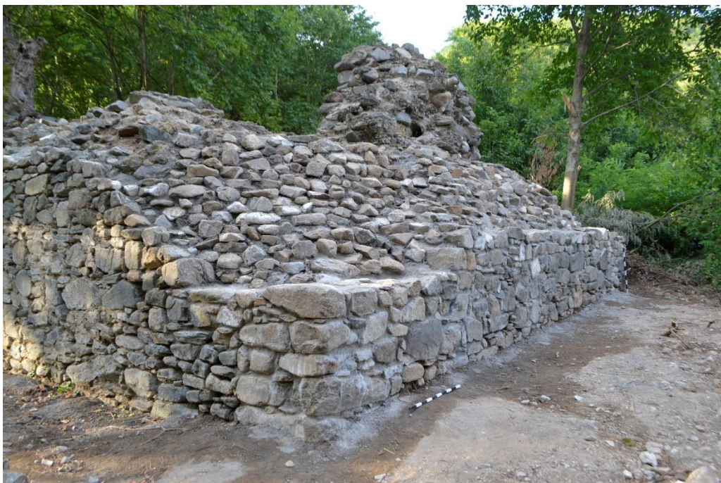
Сл.17 Северозападен сид по извршената конзервација и реставрација
