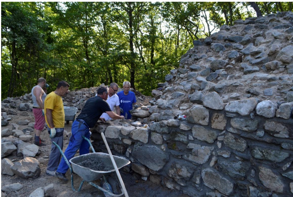
Сл.10 Во тек на конзервација и реставрација во западниот надворешен агол
