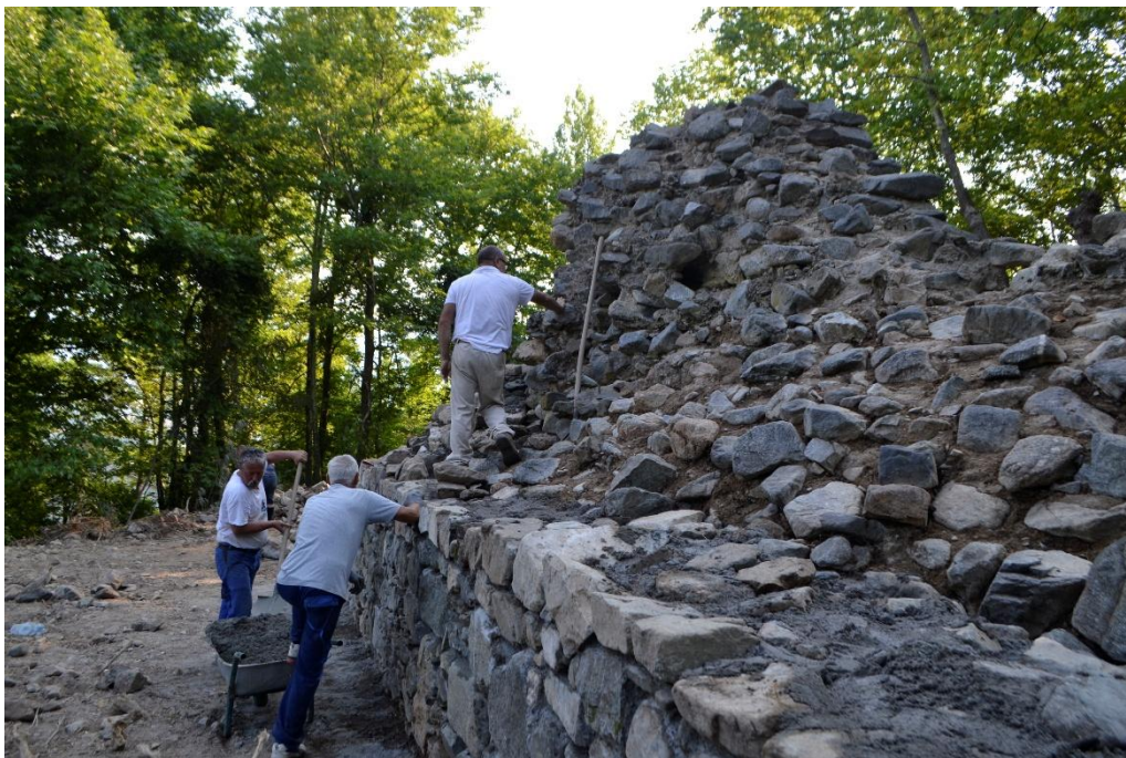
Сл.12 Во тек на конзервација и реставрација на јадрото на северозападниот сид
