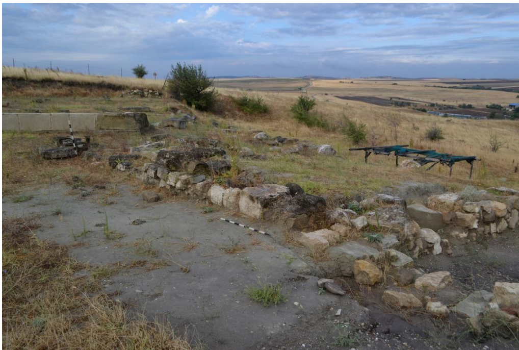
Сл.1 Источен сид пред отпочнување со конзервација и реставрација
