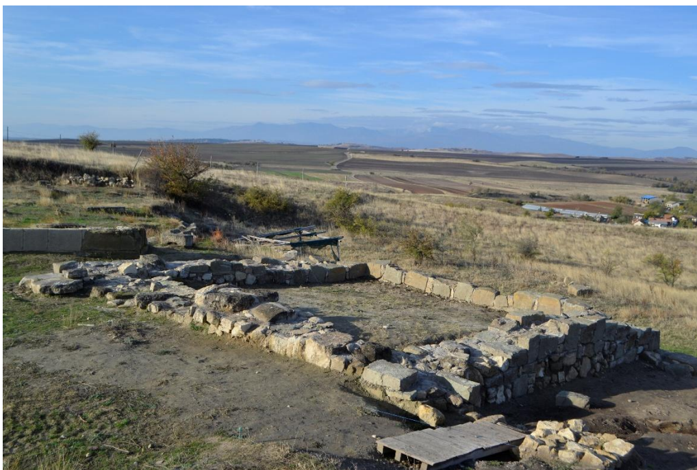
Сл.24 Панорама на објектот по конзерваторско реставраторските работи (прва фаза)
