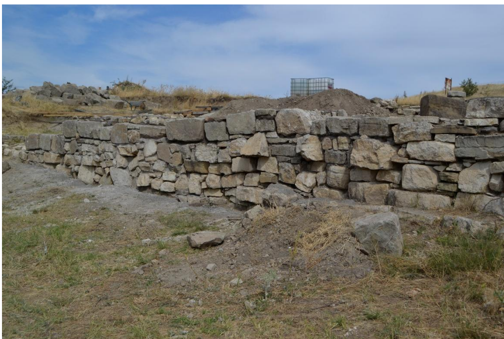
Сл.20 Западен сид по конзервацијата на фасадата на сидот
