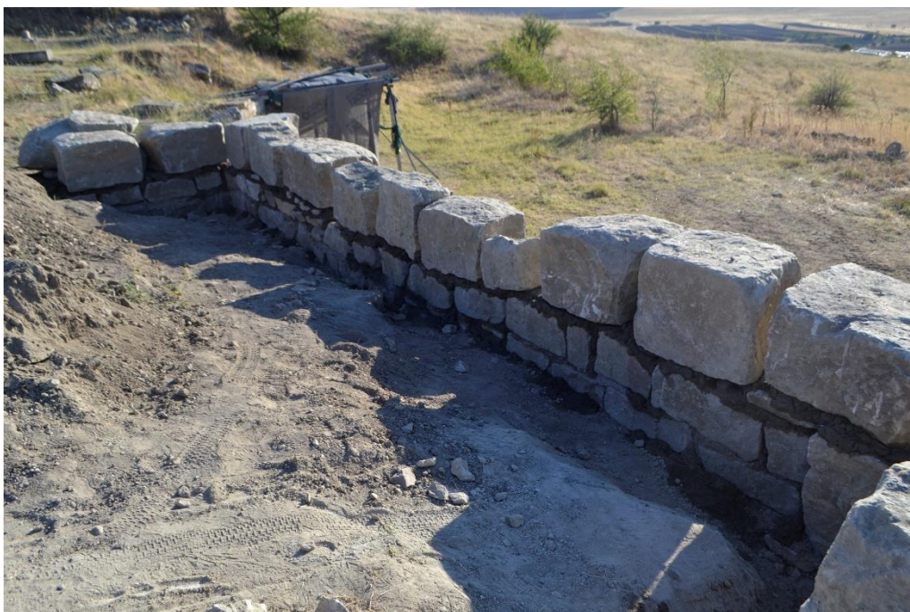
Сл.16 Западен ѕид по поставувањето на камените блокови на лицето на ѕидот
