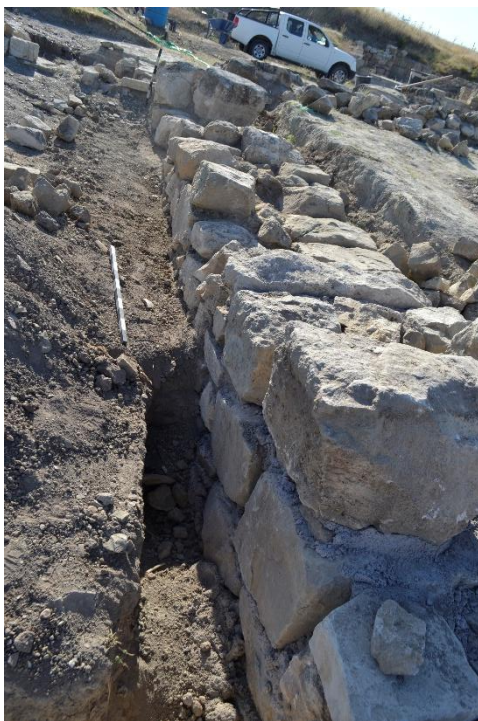
Сл.17 Северен сид во текот на конзерваторско реставраторските работи
