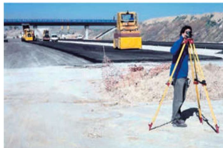
Слика 30: Обележување труп на сообраќајница
