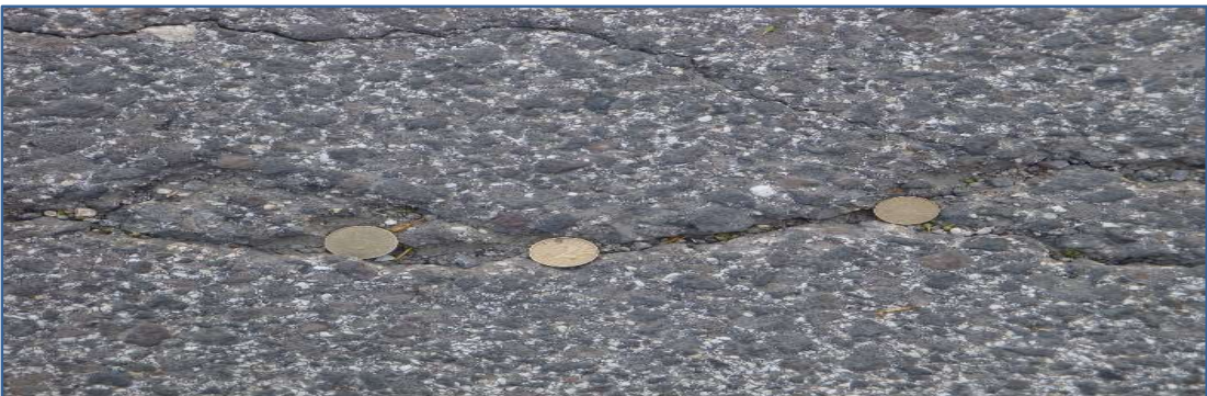
Слика 91: Попречни пукнатини на автопатот А4 делница: „Петровец – Скопје“
