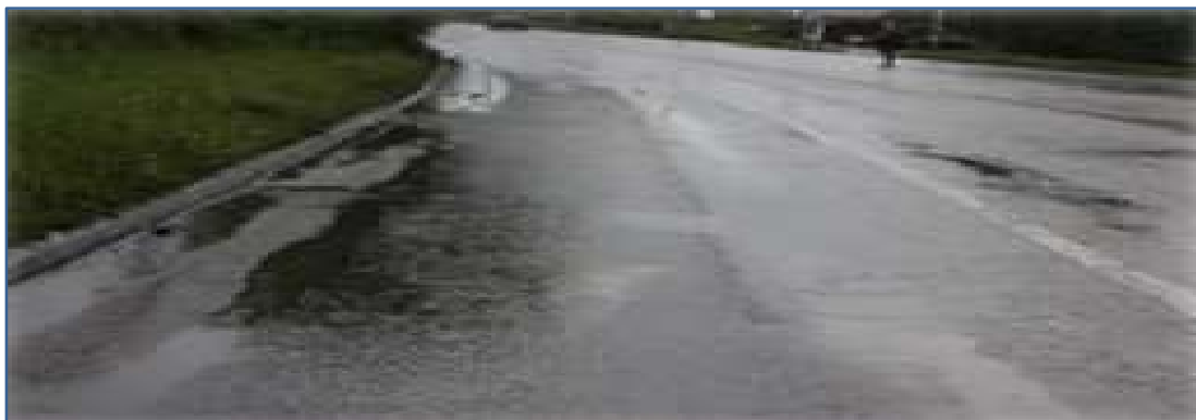
Слика 108: Задржување на вода во колотразите
