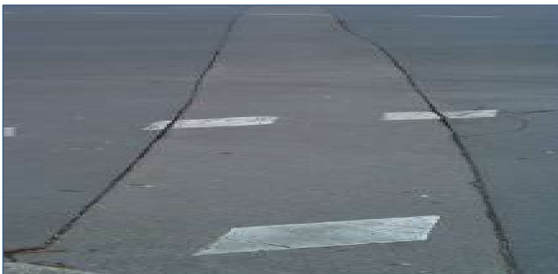
Слика 87: Попречни пукнатини на споевите/контактите на различни видови асфалтни мешавини
