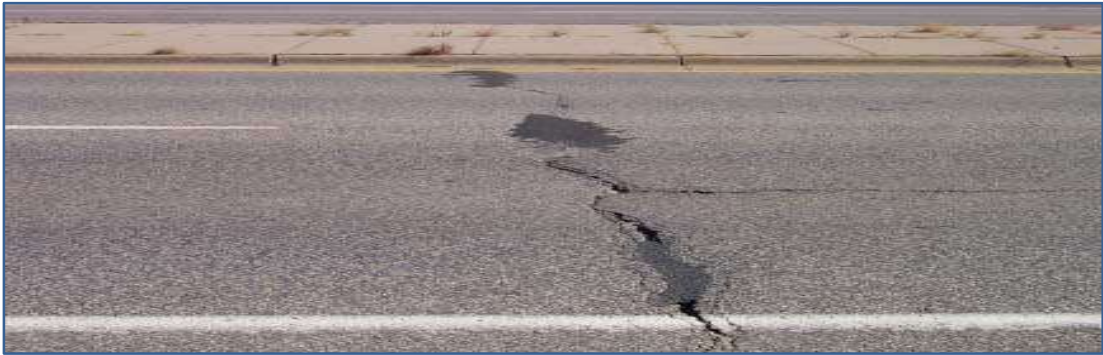
Слика 85: Високо ниво на оштетеност на коловозот со попречни пукнатини
