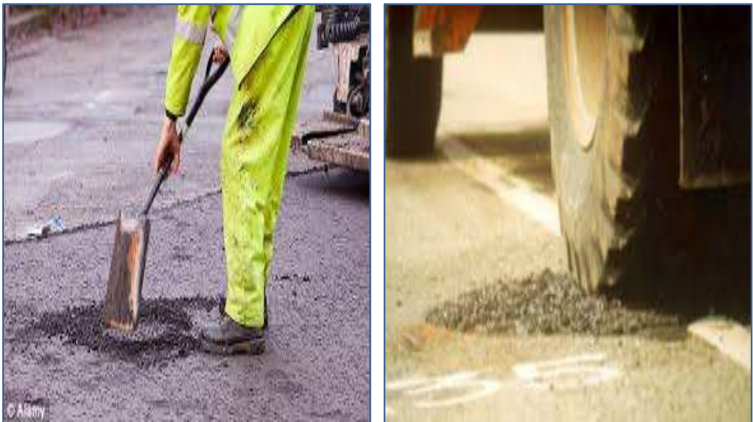
Слика 98: Техника на крпење „постави и валирај“ (зима и пролет)
