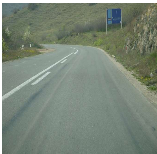
Слика 105: Колотрази без (а) и со (б) пукнатини во нив
