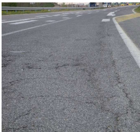
Слика 105: Колотрази без (а) и со (б) пукнатини во нив
