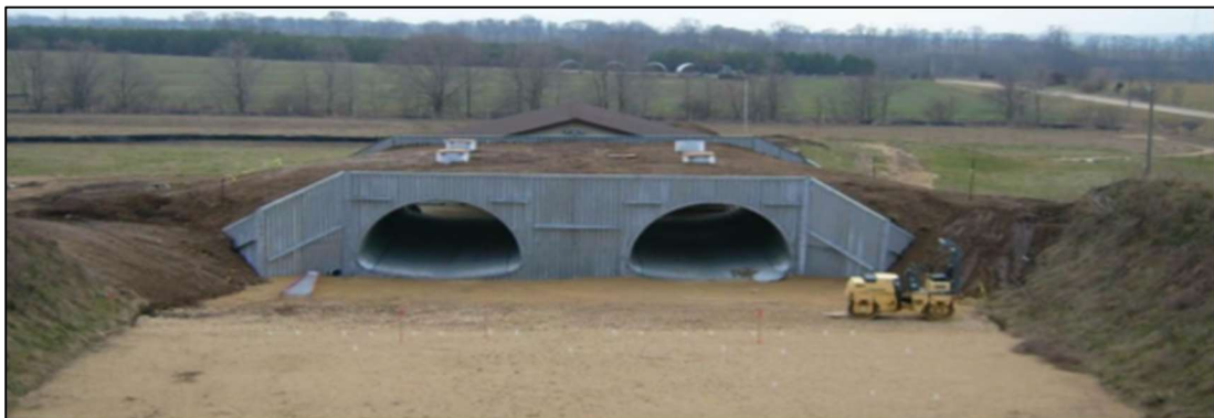
Слика 13: Параболични пропуссти за цевки делумно исполнети со вода
