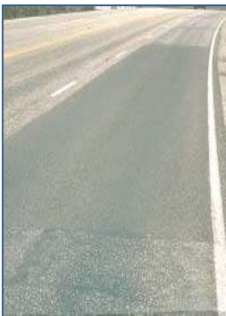
Слика 103: Оштетеност на крпениците мало(а), средно (б) и големо (в)
