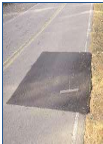
Слика 103: Оштетеност на крпениците мало(а), средно (б) и големо (в)
