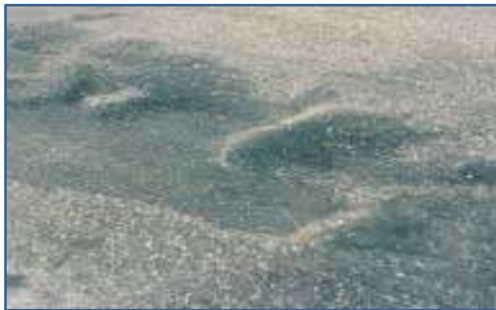
Слика 110: Набори на возната површина(а) и набори во зона на крстосница (б)
