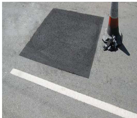
Слика 101: Финален изглед на добро закрпена дупка
