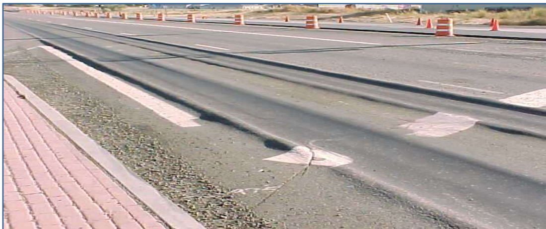
Слика 104: Колотрази (бразди) на возната површина
