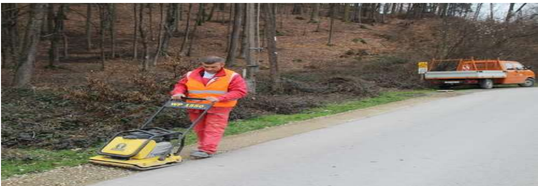
Слика 111: Одржување на банкини
