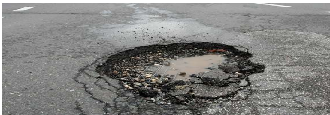
Слика 97: Изглед на дупка од големо ниво на оштетување
