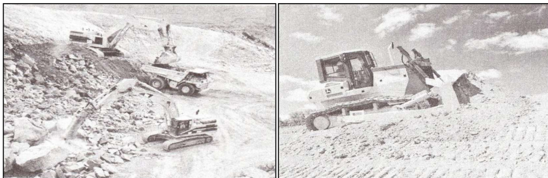
Слика 46: Широк откоп со багер и со булдожер
