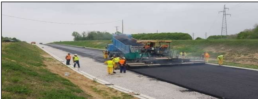
Слика 49: Вградување на асфалтна мешавина
