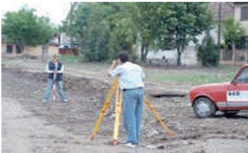
Слика 30: Обележување труп на сообраќајница
