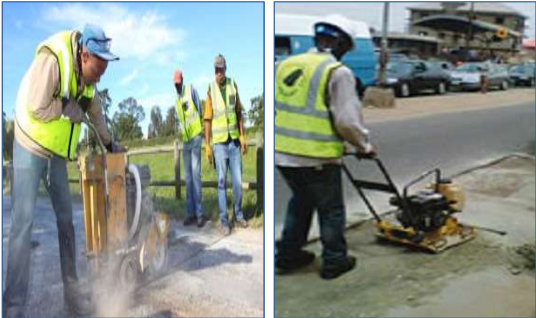
Слика 99: „Полупостојан“ метод за санација
