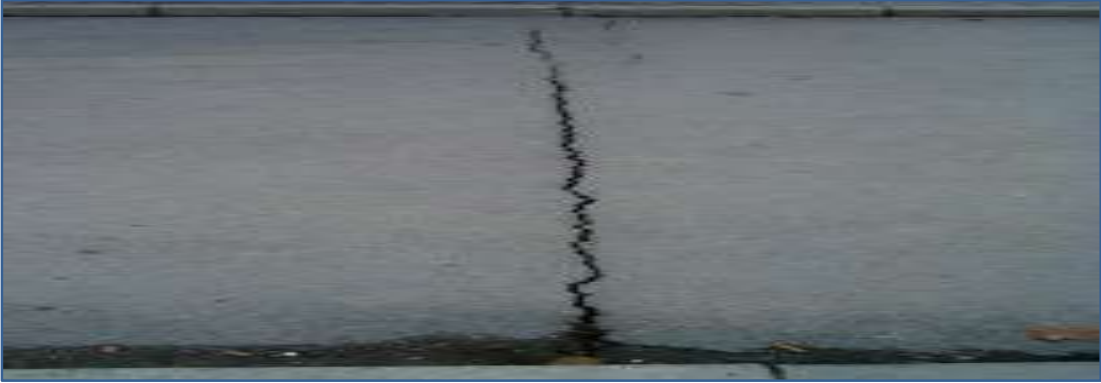
Слика 89: Појава на попречни „термички“ пукнатини поради ниски температури во коловозната конструкција
