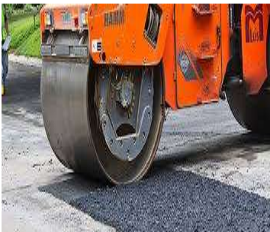
Слика 101: Финален изглед на добро закрпена дупка
