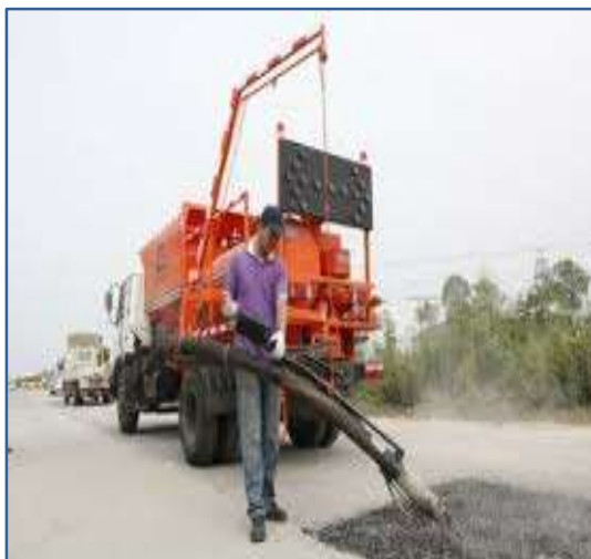
Слика 100: Поставување на материјал во дупката со вбризување односно инјектирање
