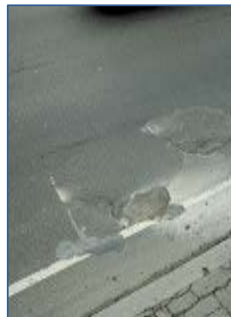
Слика 103: Оштетеност на крпениците мало(а), средно (б) и големо (в)
