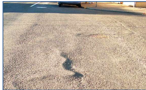
Слика 110: Набори на возната површина(а) и набори во зона на крстосница (б)
