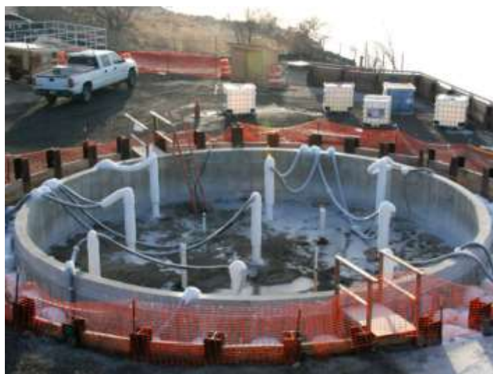
Слика 1. Метода со вештачко замрзнување на тлото [5]
