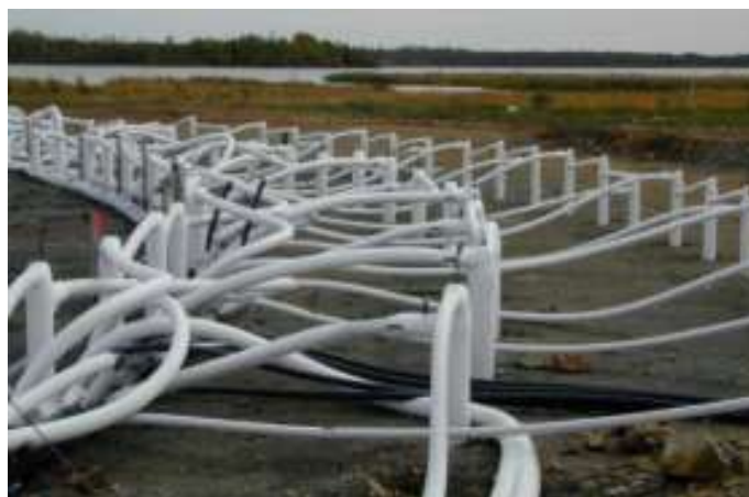
Слика 4. Конфигурација на цевката за замрзнување
