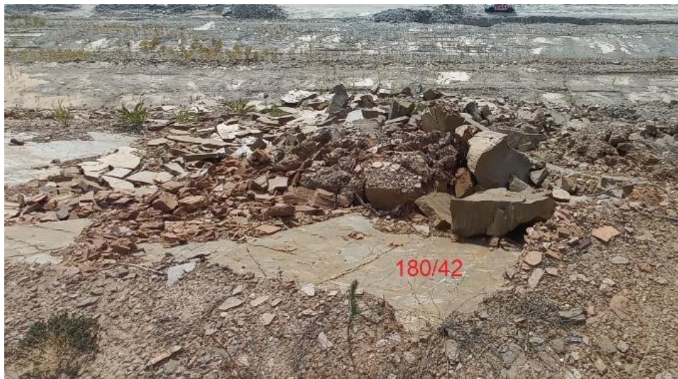
Слика 30 Најновата нестабилност се појави по фолијација од 180/42^\circ
