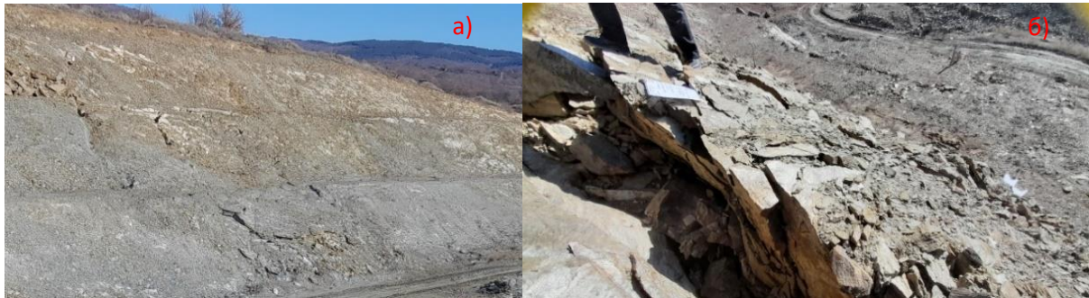
Слика 27 а) Нестабилна зона на десна страна на усекот. б) Отворена рамна пукнатина
