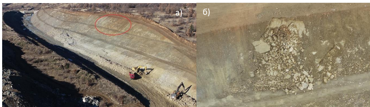
Слика 124 а) Состојба на усекот пред да се случи новото свлечиште во делот на црвениот круг. б) Состојба со новото свлечиште на 27.09.2023
