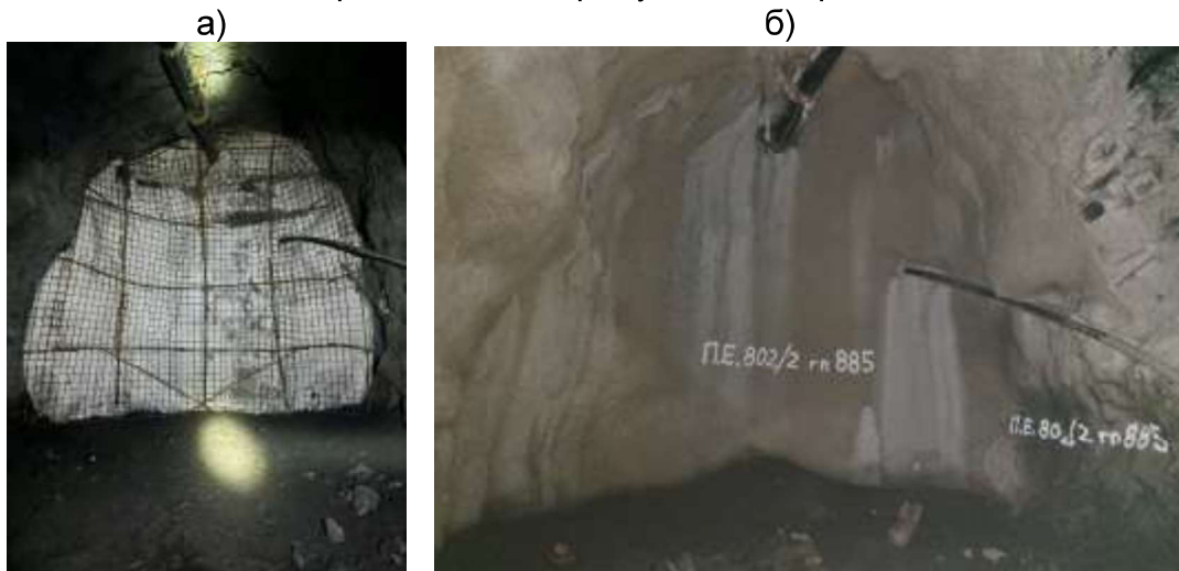
Слика 4. Лачна барикада од прскан бетон, а) метална конструкција, б) финален изглед [6]
