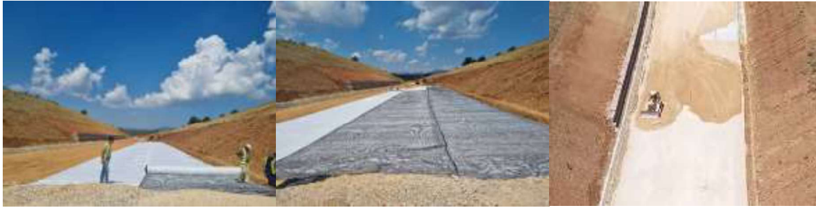
Слика 12. Подобрување на подлогата
