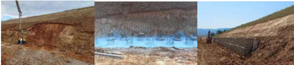
Слика 13. Изработка на потпорна конструкција
