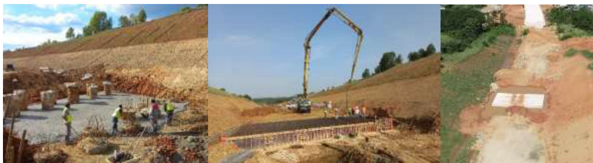
Слика 11. Изработка на колови и преодна плоча
