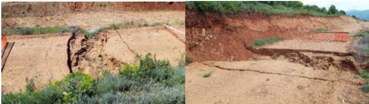
Слика 3. Пропаѓање на земјиште кај нископ 1
