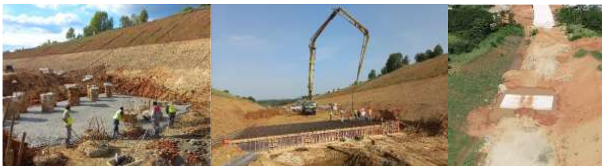
Слика 11. Изработка на колови и преодна плоча
