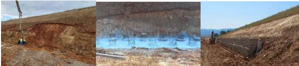
Слика 13. Изработка на потпорна конструкција
