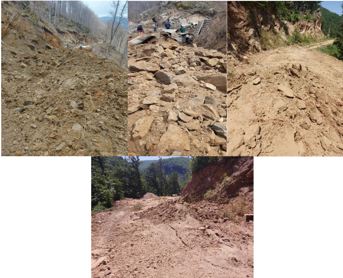
Слика 10. Ефекти од минирање на канал со корегирани параметри
