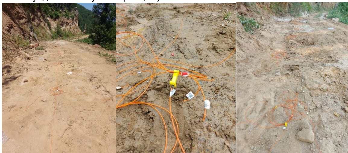
Слика 8. Начин на поврзување на мински дупчотини
