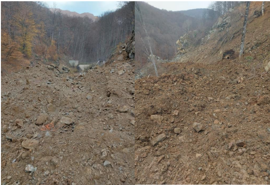
Слика 9. Ефекти од минирање на канал со пречник на дупчење \phi 105 mm и тип на експлозив Amoneks \phi 70
