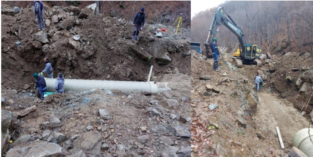
Слика 5. Поставување на цевки во каналот
