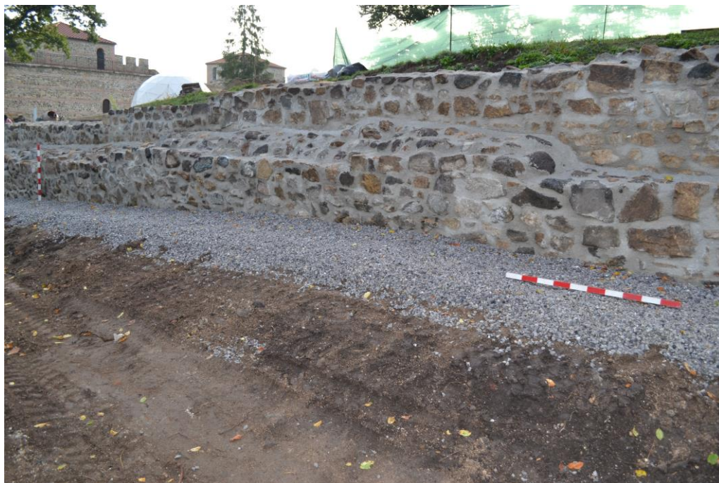
Сл. 10 Одбранбен западен ѕид, западна фасада (сектор 8), по конзервацијата
