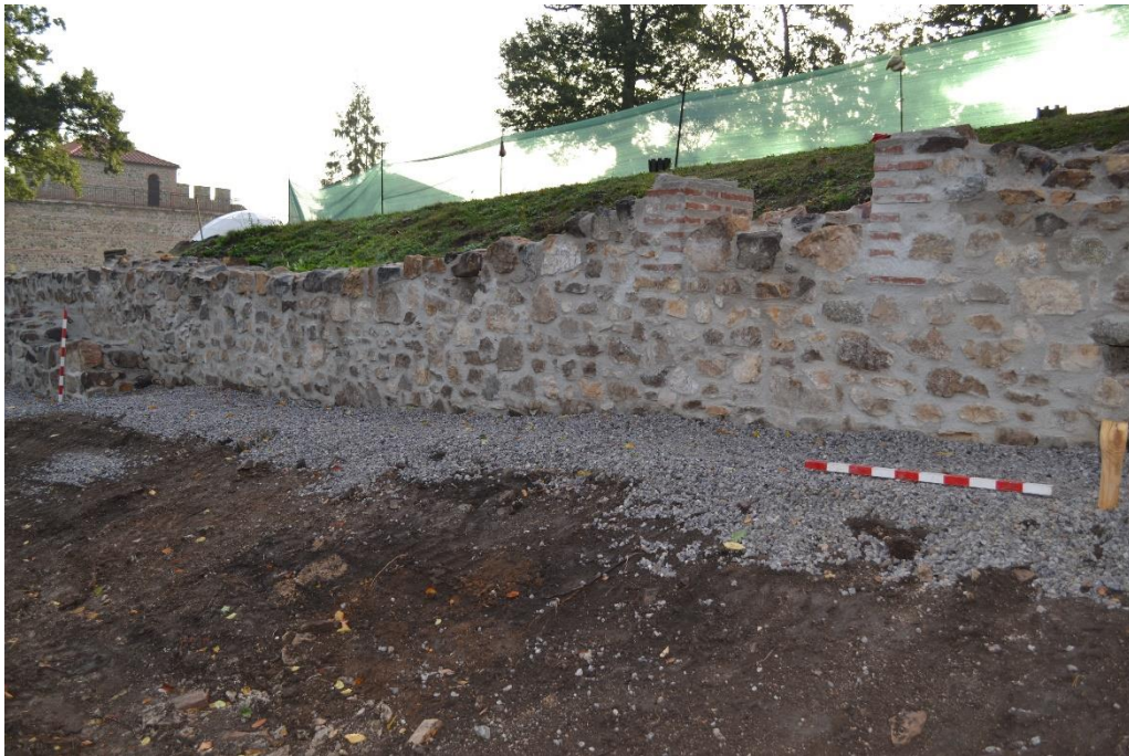
Сл.6 Одбранбен западен ѕид, западна фасада (сектор 7),по конзервацијата
