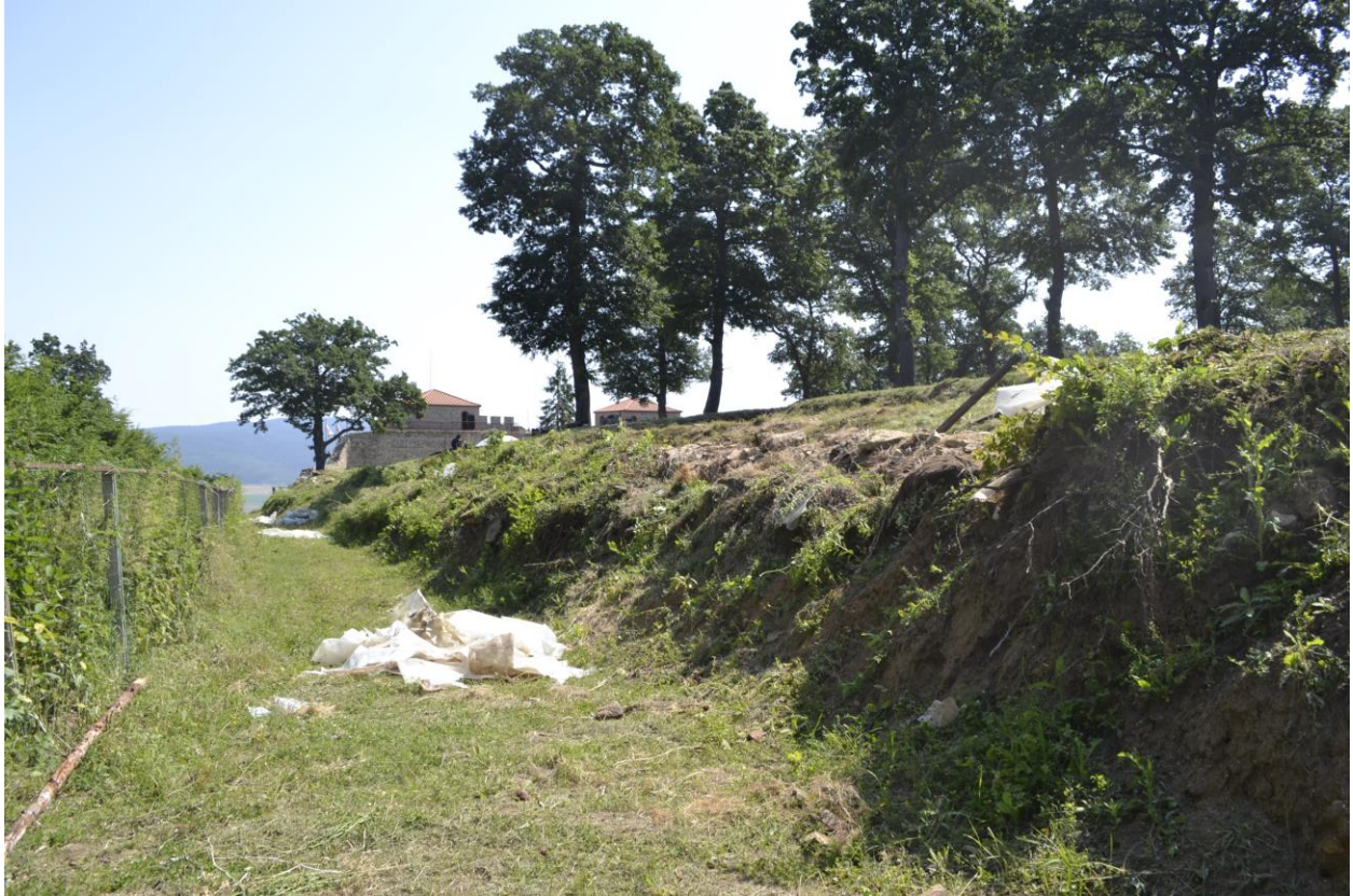
Сл.1 Поглед од југ на западната фасада на западниот одбранбен ѕид од фортификацијата
