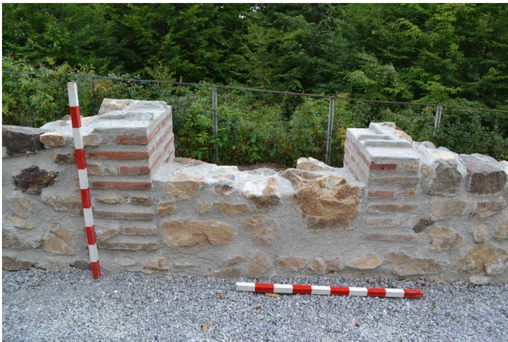
Сл.7 Одбранбен западен ѕид, источна фасада – потерна (сектор 7), по конзервацијата
