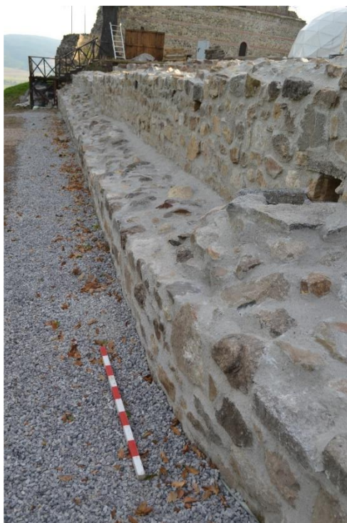
Сл.14 Одбранбен западен ѕид, западна фасада (сектор 10,11 и 12), по конзервацијата
