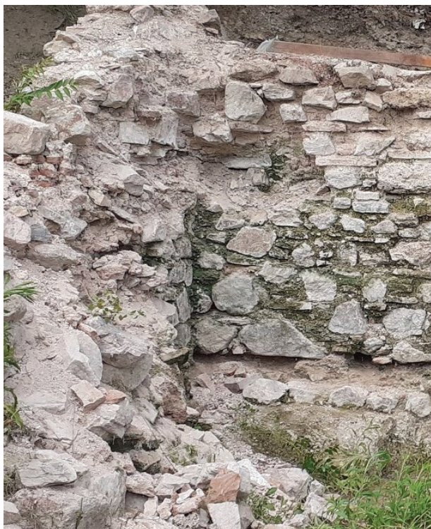
Ил. 3 - Дејтал од ѕрадежна шехника opus incertum на зајадниој ѕуг. Fig. 3 - Detail from constructive technique opus incertum on the western wall.
