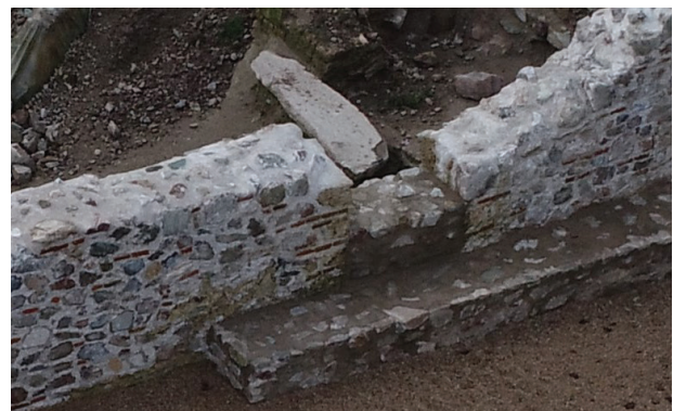
Ил. 14 - Клуѓа за седење по конзервацијата и реконструкцијата.
