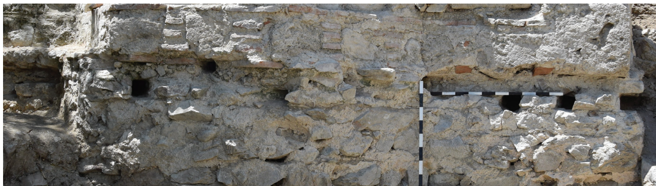
Ил. 2 - Детал од градежната техника Semi opus cloisonné cum lignum на источниот ѕид.
