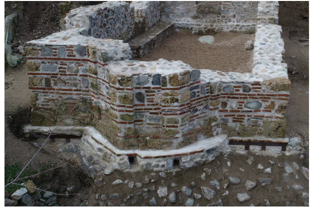
Ил. 12 - Источен ѕид на средновековната црква по конзервацијата, реставрацијата и делумната реконструкција.
