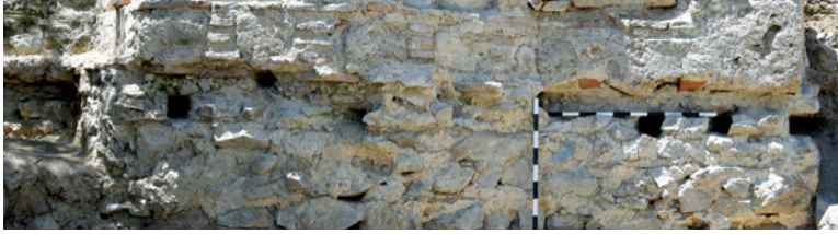
Фиг. 9d. Остатоци од скриен сантрач систем на Средновековната црква во подножјето на Цареви Кули – Струмица.
