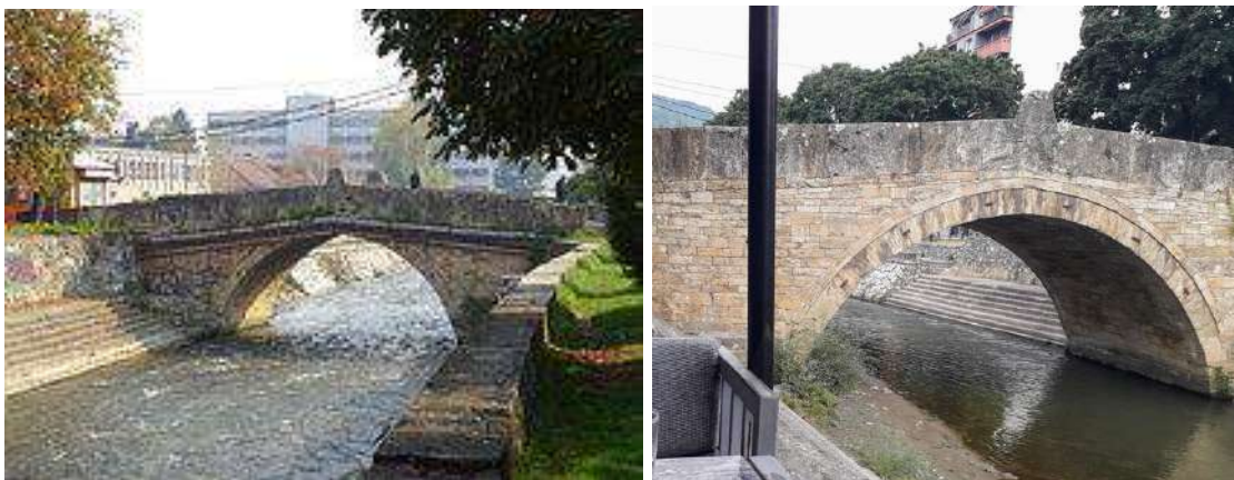
Слики бр.52, 53: Мостот на Топџиите Figure no.52, 53 Gunner's Bridge
