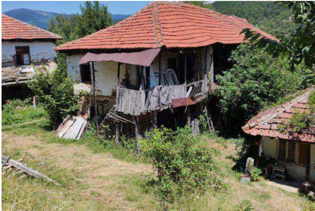
Слика бр.76 Стара куќа во село Железна Река Figure no.76 An old house in the village of Zhelezna Reka
