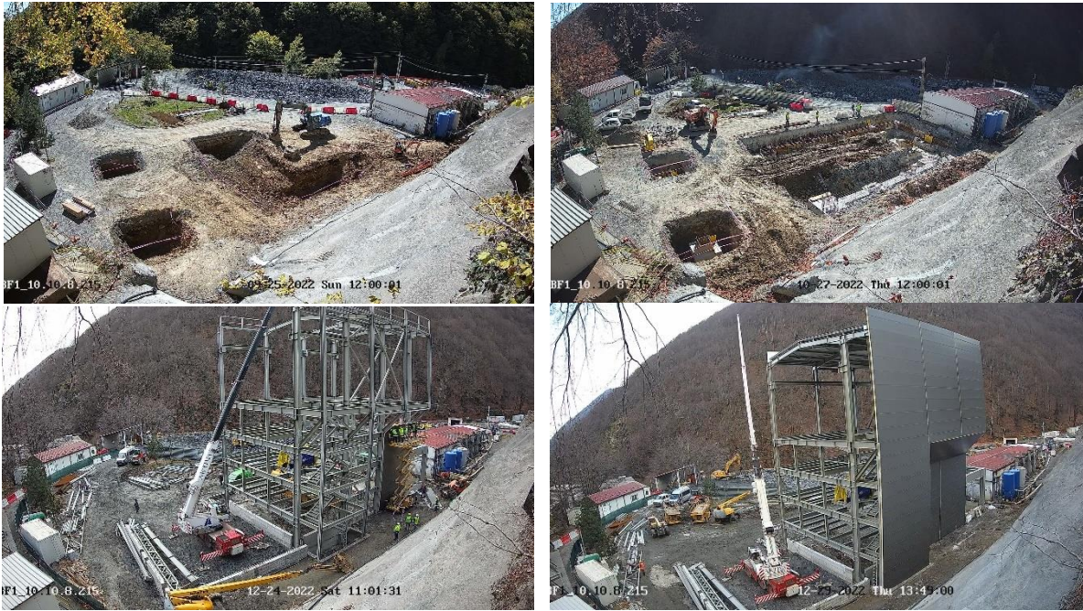
Слика 2. Процес на изградба на Постројката – ископ, темелење, челична конструкција, фасадни панели
