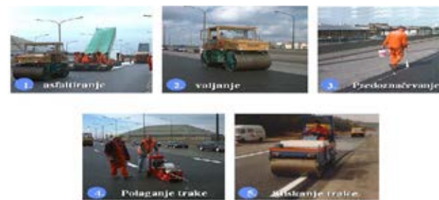
Слика 7. Поставување на надолжна ознака на коловоз изработени со апликативна трака
