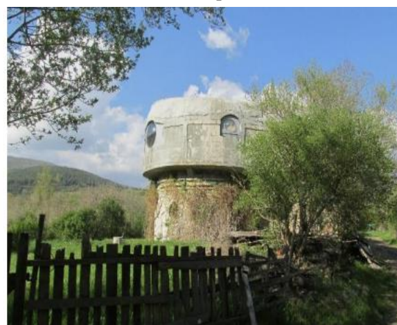
Слика 72г: Објект на излезот од селото
