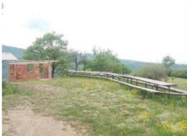
Слика 5а: Простор со верски објект во изградба
