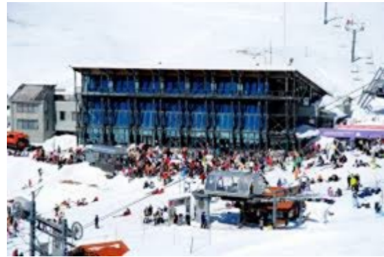
Слика 20: Парнасос, Грција
