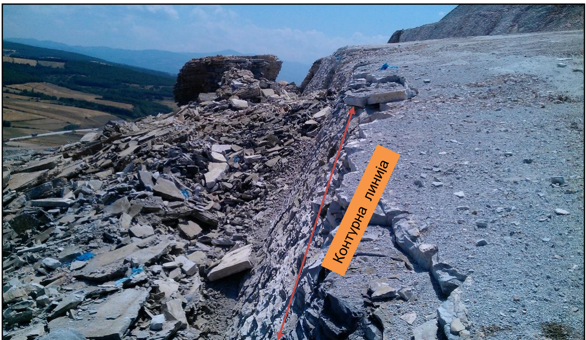
Слика 8.3. Поглед одблизу на резултатите од минирање на контурата, со еден до три редови примарни дупчотини Figure 8.3. Close-up view of contour blasting results, with one to three rows of production drillings
