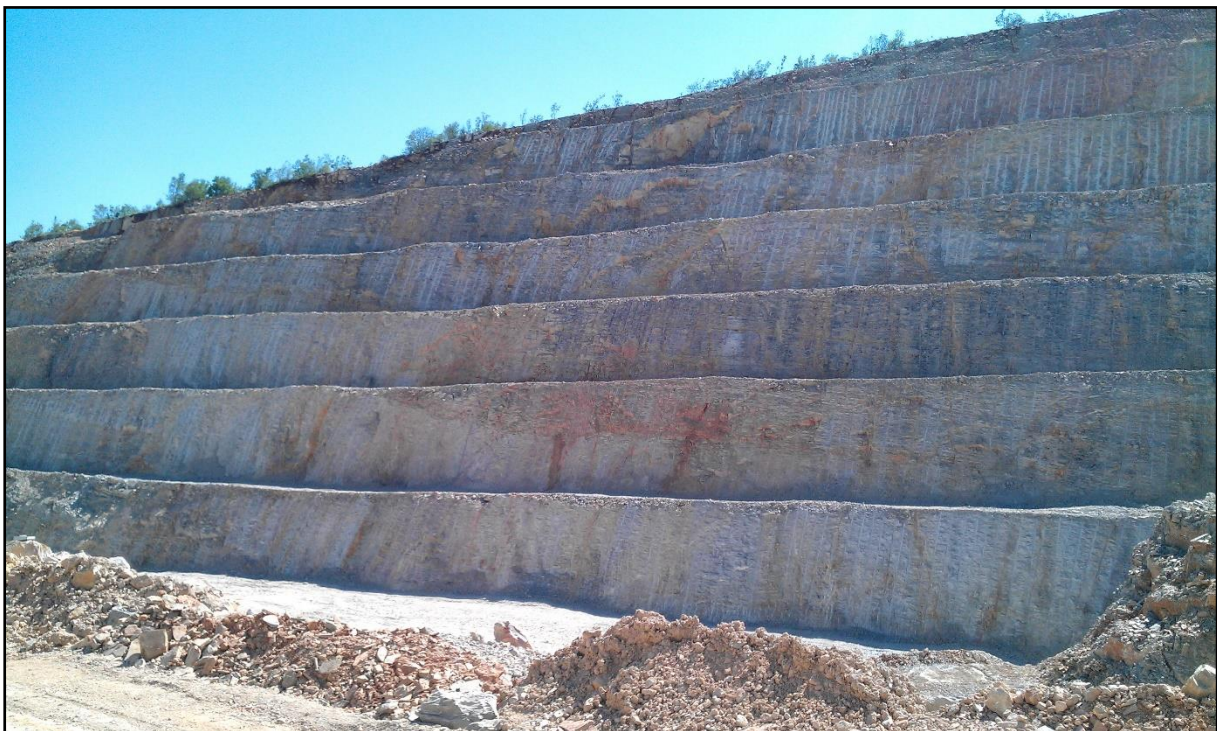
Слика 8.8. Поглед на контурните дупки по косината од етажата Figure 8.8. View of contour drillings on the bench slope
