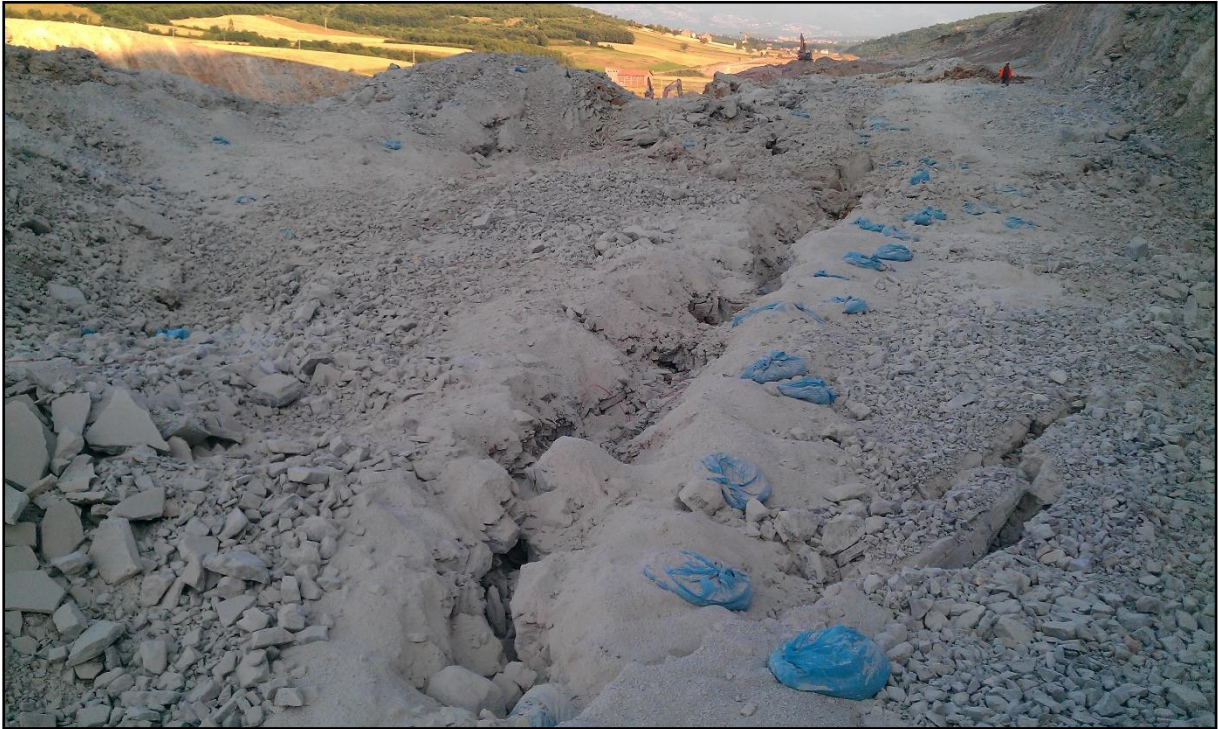
Слика 8.6. Поглед на случај на минирање на контура, со повеќе од 4 (четири) редови на примарни дупчотини
