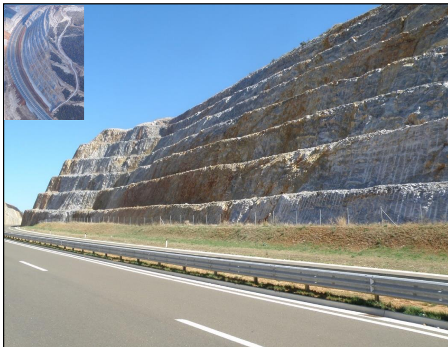
Слика 8.14. Поглед на падините, формирани од експлозии при контурно минирање, по проширување на автопатот
