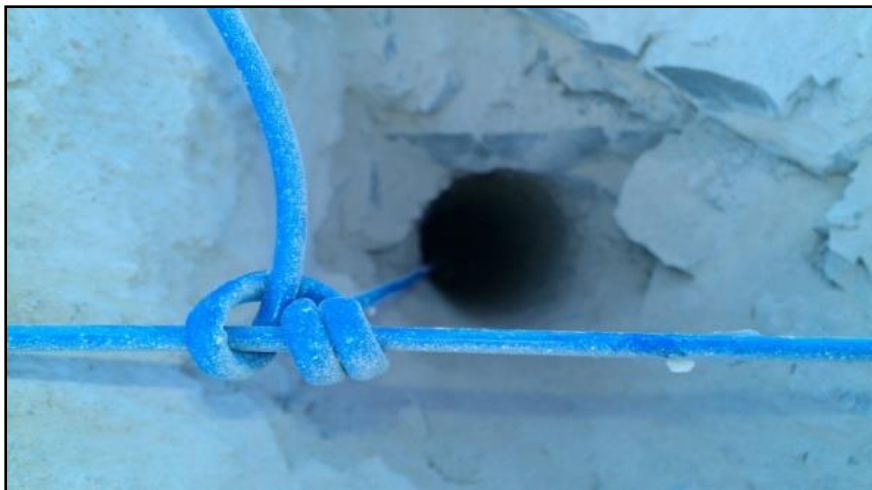
Слика 6.4. Приказ на поврзување на детонаторски фитил со главната линија Figure 6.4. The appearance of the detonating cord connection of contour drilling to the main line of detonating cord
