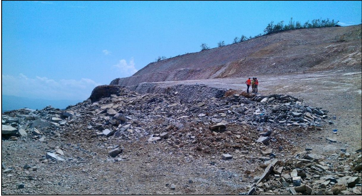
Слика 8.4. Поглед од далечина на резултатите од минирање на контура, со еден до три реда примарни дупчотини Figure 8.4. View from a distance of the results of contour blasting, with one to three rows of production drillings
