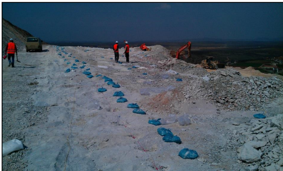
Слика 4.19. Поглед на полето со контурни мински дупчотини Figure 4.19. View of the field with contour drillings
