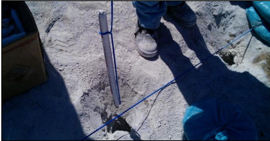
Слика 6.3. Приказ на пуштање на првиот патрон-ударен во контурните дупчотини Figure 6.3. The appearance of placing the first cartridge in the contour drilling
