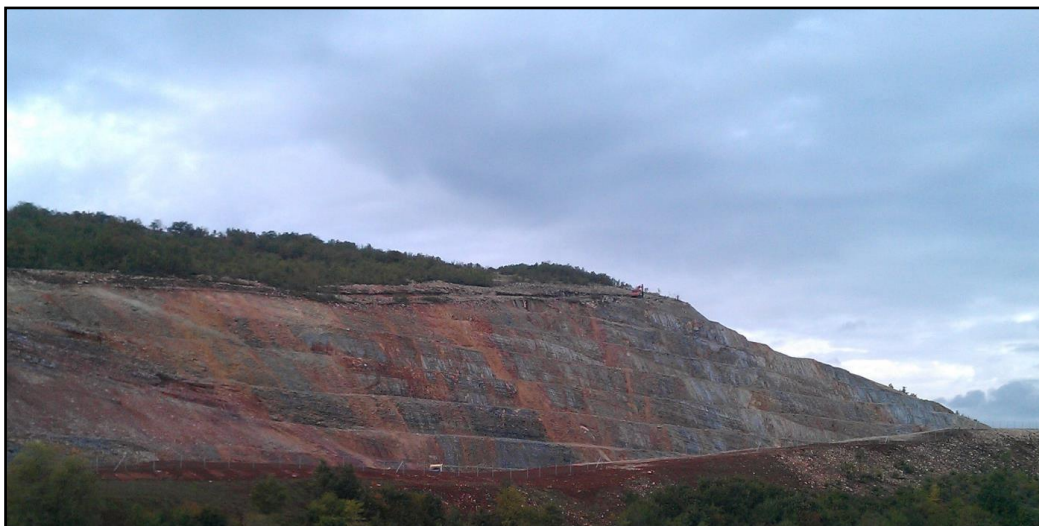
Слика 8.13. Поглед на етажите, формирани при контурни минирања на автопатот кај Беланица
