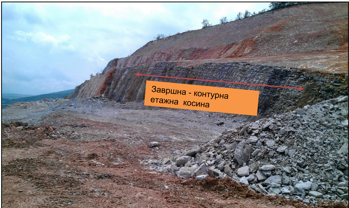
Слика 8.5. Поглед по отстранување на минираниот материјал за отсекување на косина од етажа со контурно минирање, со еден до три реда примарни дупки Figure 8.5. The view after removing the mined material of cutting the bench with contour blasting, with one to three rows of production drillings
