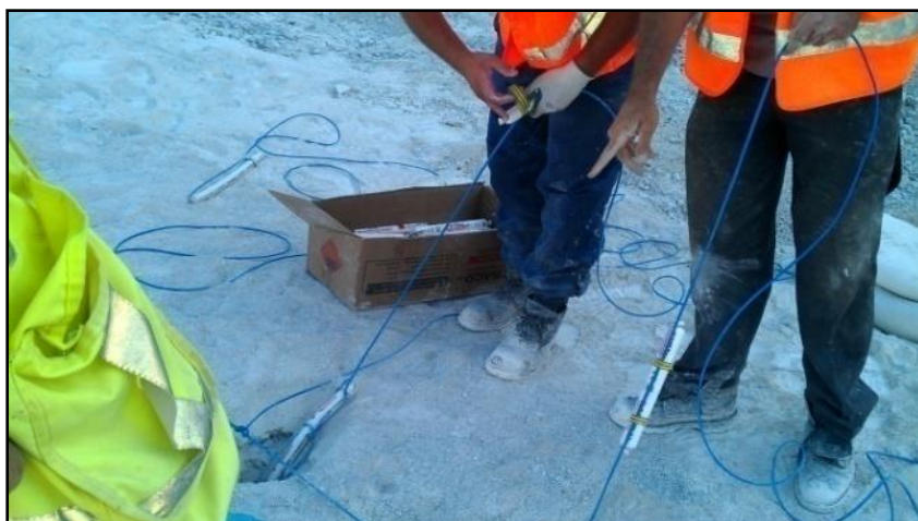
Слика 6.5. Процедура на полнење на контурните дупчотини Figure 6.5. The procedure of filling the contour drilling
