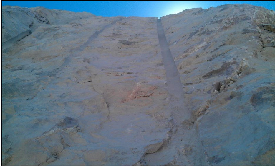
Слика 8.8. Поглед на контурните дупки по косината од етажата Figure 8.8. View of contour drillings on the bench slope
