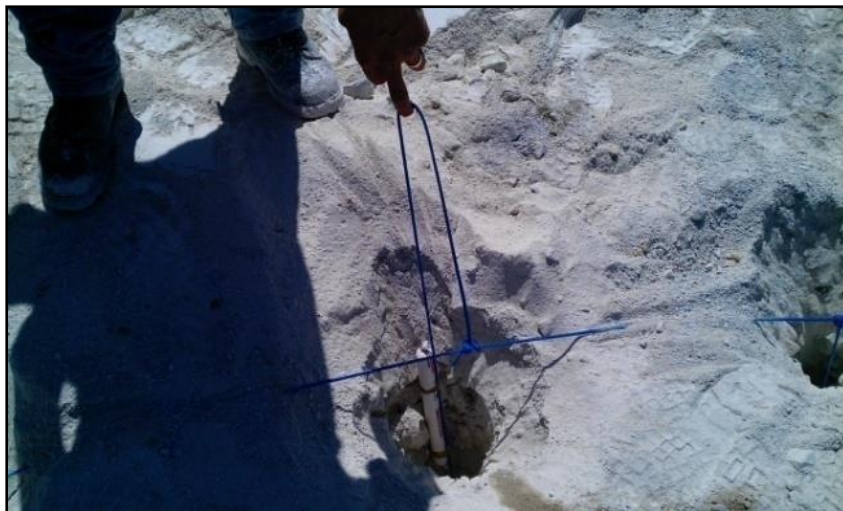
Слика 6.6. Приказ на врзани патрони на растојание од 0.6[m] Figure 6.6. The length of the yarn cartridges with distance of 0.6 [m]
