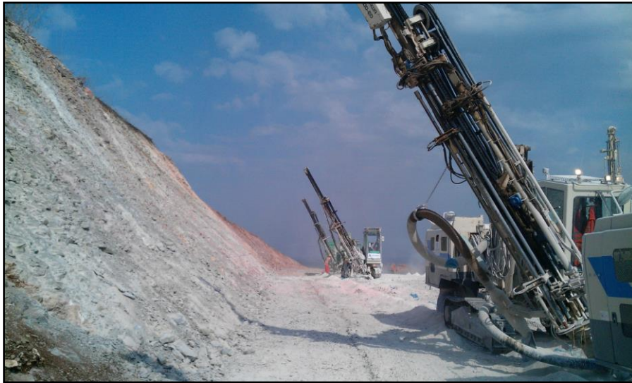
Слика 4.18. Поглед на процесот на дупчење на контурните дупчотини Figure 4.18. View of the process of drilling of the contour drillings
