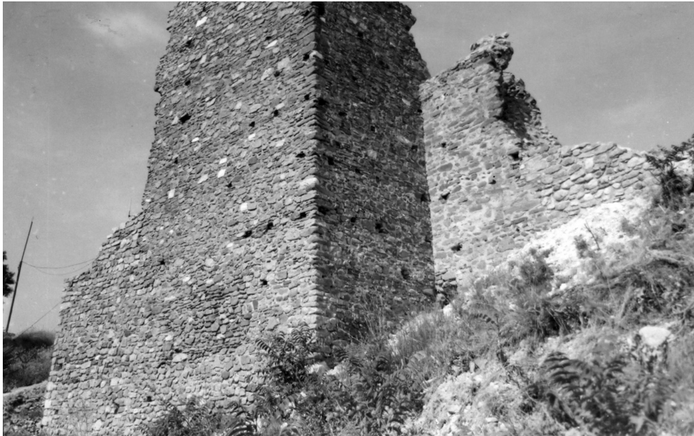
Сл.8. Источен ѕид на кула 2 по конзерваторско реставраторските работи
