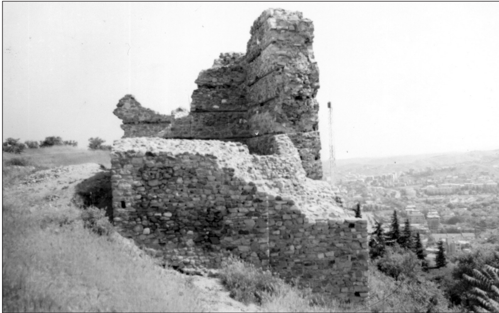
Сл.9. Јужен ѕид кула 2 по конзерваторско реставраторските работи
