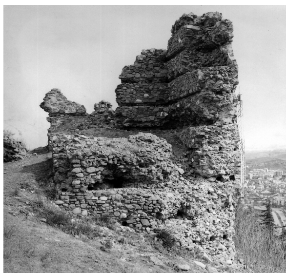
Сл.5. Јужен сид на кула 2 пред конзерваторско реставраторски работи
