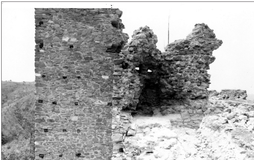
Сл.10. Северен ѕид на кула 2 по конзерваторско реставраторските работи
