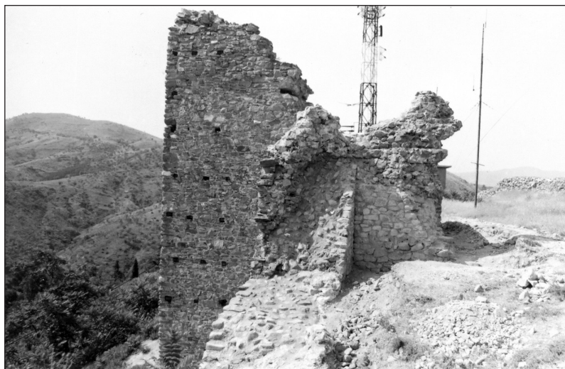
Сл. 12. Дел од фортификацијата помеѓу северниот сид на кула и јужниот доворотник од влезот на акрополот, по конзерваторско реставраторските работи
