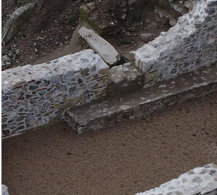
Сл.5 Јужниот влез и клупата за седење по конзервацијата и реставрацијата
