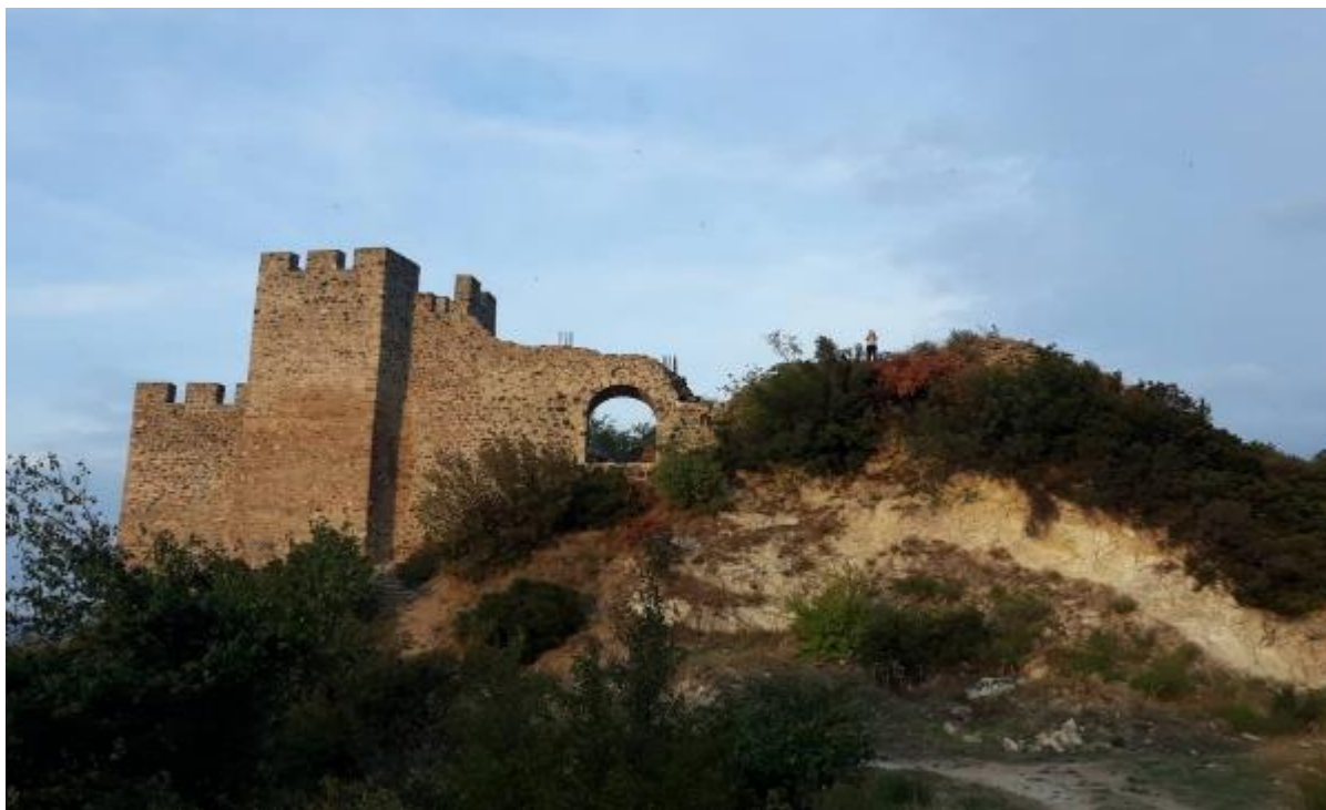
Слика 41. Западен влез на Цареви Кули Figure 41 West entrance to the Tsar's Towers
