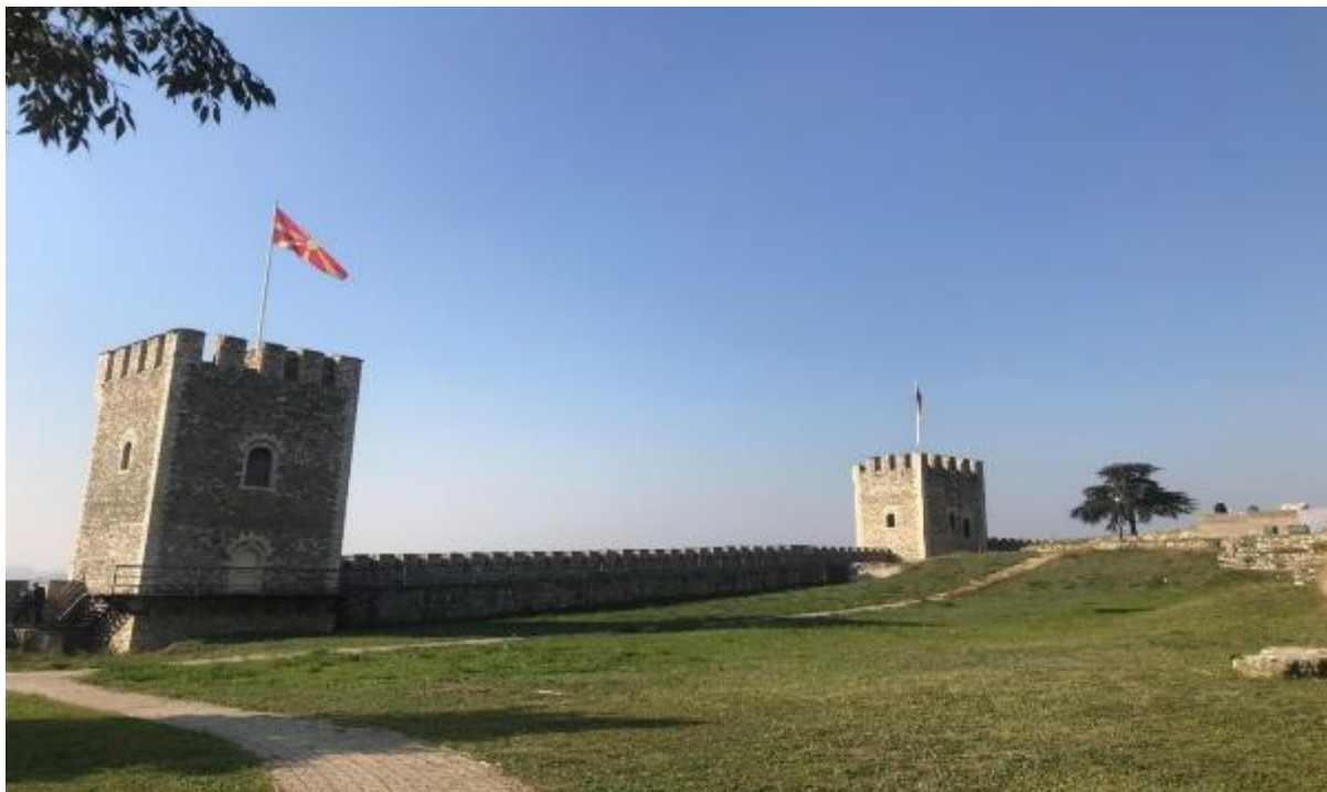
Слика 28. Западниот ѕид на Скопската тврдина и двете кули Figure 28. The western wall of the The western wall of the Skopje fortress and the two towers
