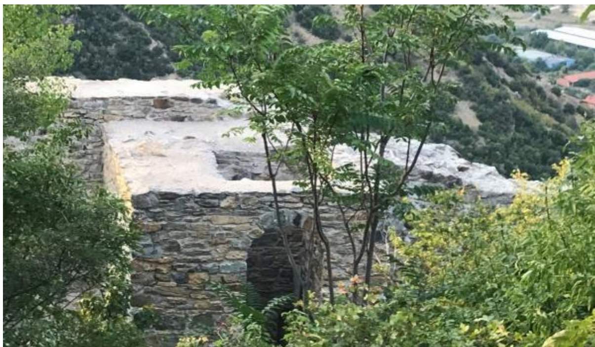
Слика 42. Остатоци од објекти во внатрешноста на Цареви Кули Figure 42. Remains of buildings inside the Tsar's Towers
