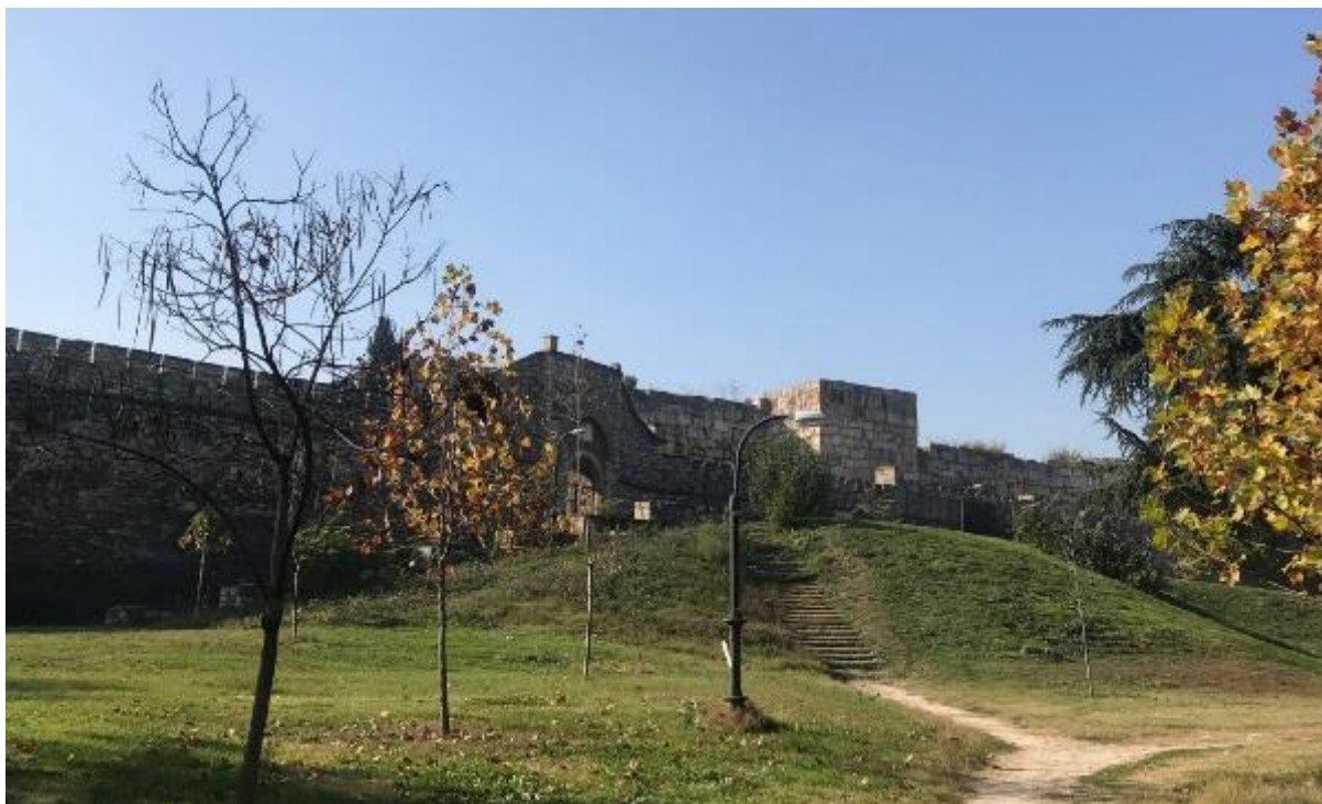
Слика 27. Главниот источен влез на Кале 9 и 10 Figure 27. The main east entrance of Kale 9 and 10
