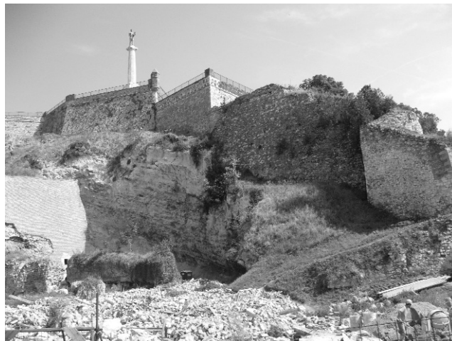
Сл. 6. Радови на реконструкцији и санацији спољнег зида тврђаве (Фото Љ. Рундић: 04.09.2009.) Fig. 6. Kalemegdan fortress under reconstruction (Photo by Lj.Rundic)
