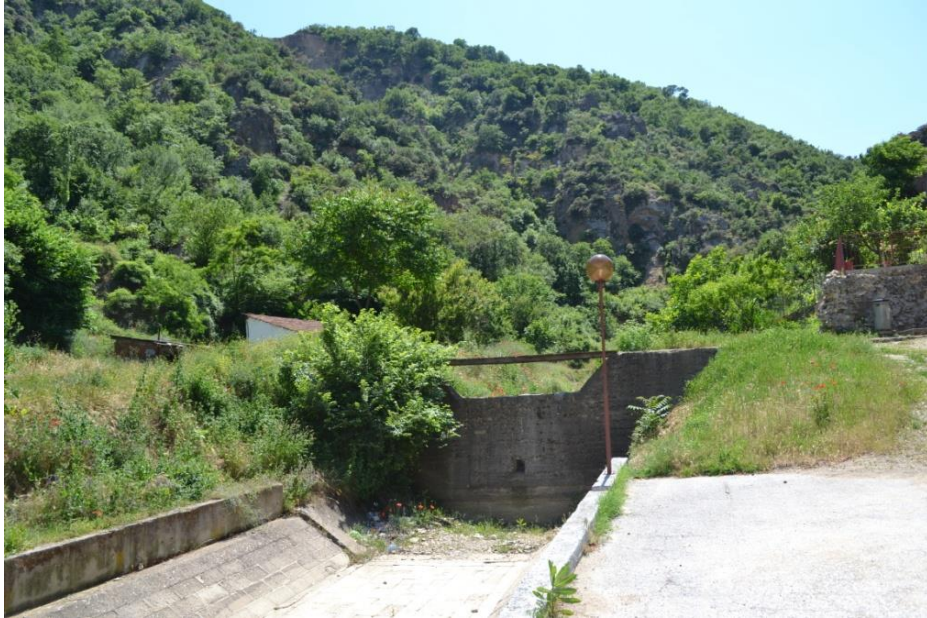
Слика 68. Почеток на одводниот канал за поројот на западниот дел од ридот Одводниот ободен канал е бетонски со сложен попречен пресек, т.е. трапезен попречен пресек на минор коритото, и правоаголен на мајор коритото (Слика 69).
