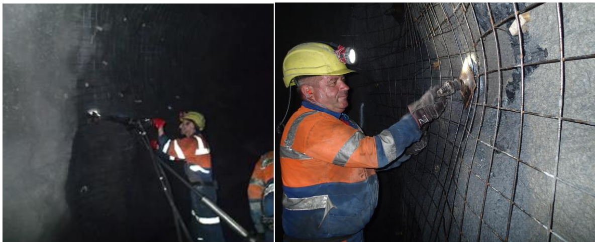
Слика 4. Вградување на “SN” анкери со навој по целата должина во рудникот за олово и цинк САСА
