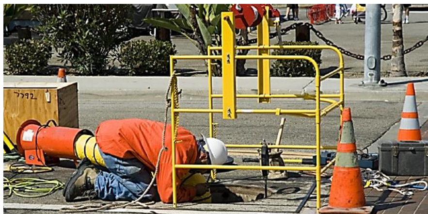
Слика 1. Оградување на затворениот простор
