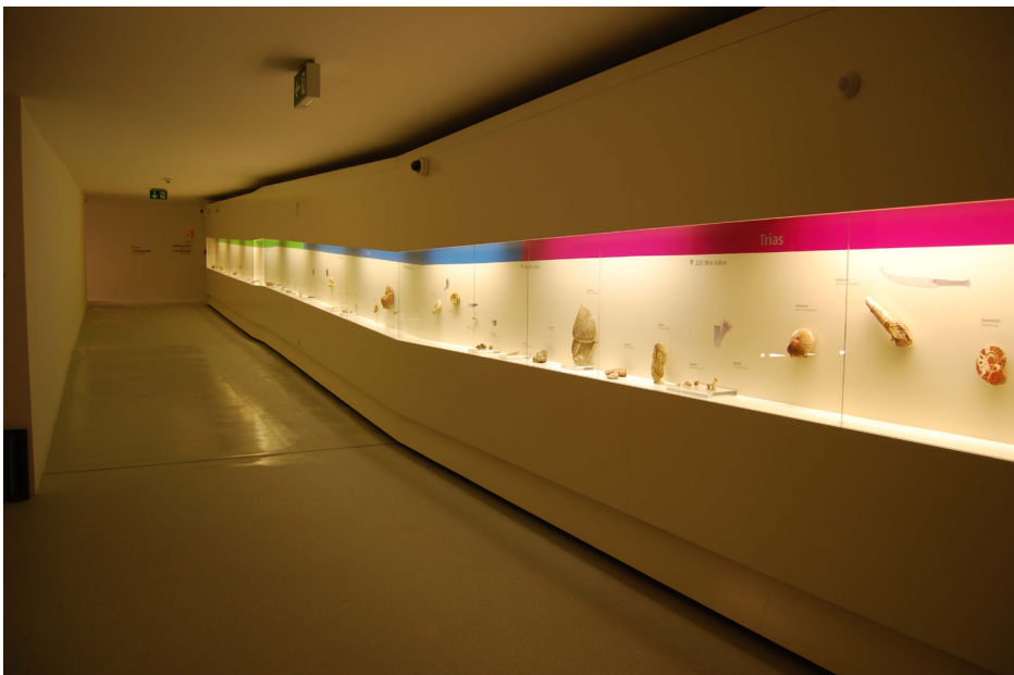
Вградени светилки во витрина, како дел од ѕидна конструкција, од изложбен простор - Schloss museum, Linz, Austria, 2009
