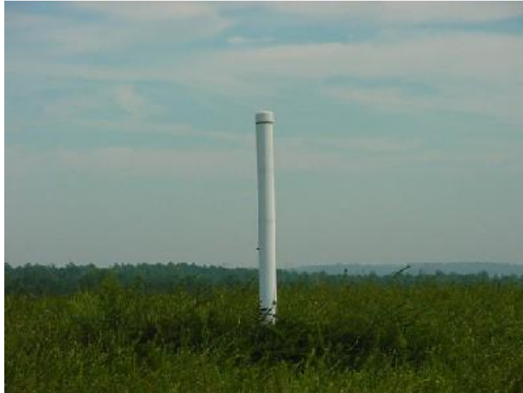
Слика 8.6: Собирната цевка на метан помага во прифаќање на опасните гасови Figure 8.6: A methane collection pipe helps capture the hazardous gas
