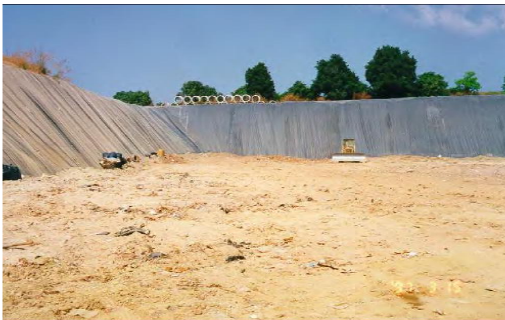
Слика 8.12: Изградба на клетки Figure 8.12: Construction of Waste Cells
