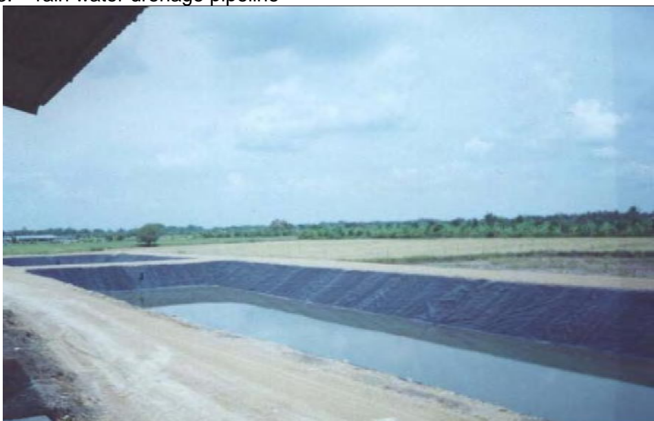
Слика 8.9: Езеро за исцедок Figure 8.9: Leachate Pond
