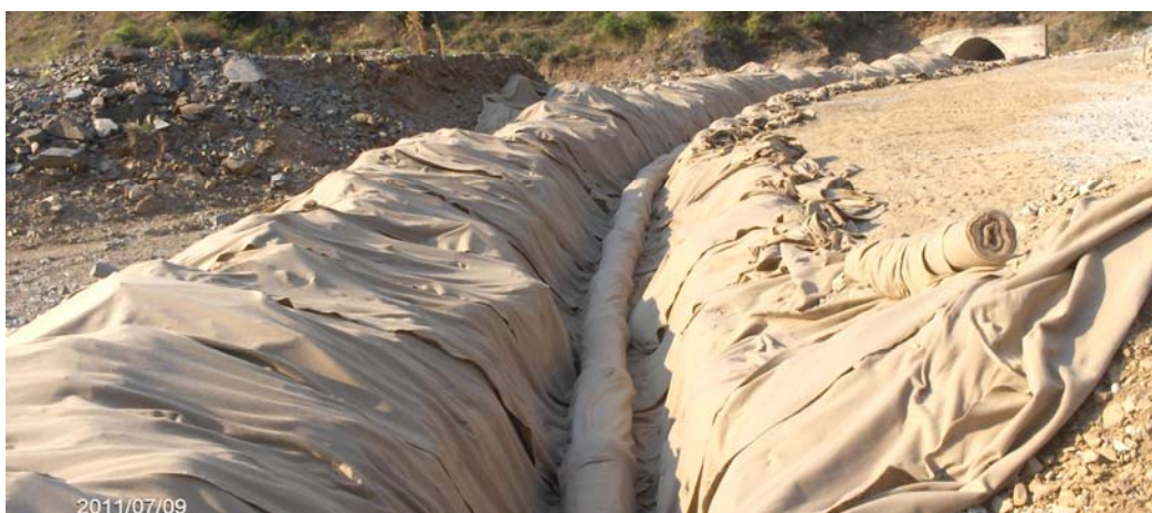
Слика 71. Дренажни цевки обвиткани со геотекстил Figure 71. Drainage pipes with geotextile
