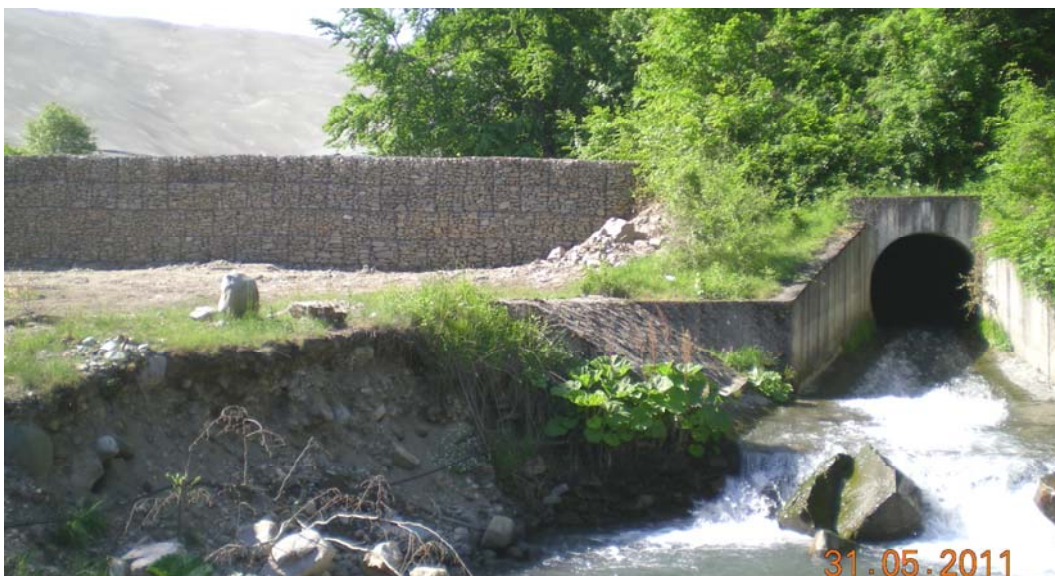
Слика 83. Габионскиот ѕид непосредно до опточен тунел Figure 83. Wall from gabions near tunnel
