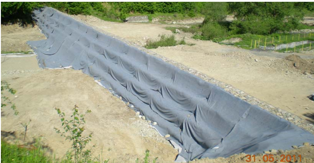
Слика 82. Габионски ѕид Figure 82. Wall from gabions
