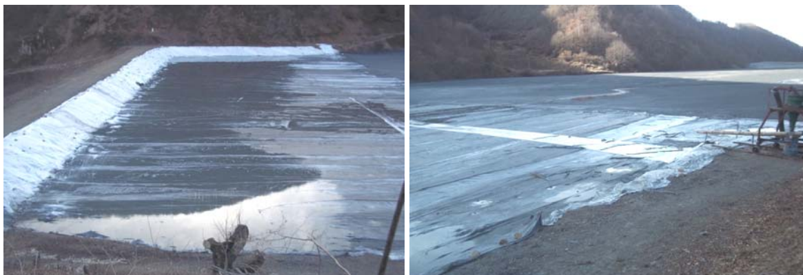
Слика 88. Поставен геотекстил на ретензионата брана Figure 88. Lined geotextile on the retention dam
