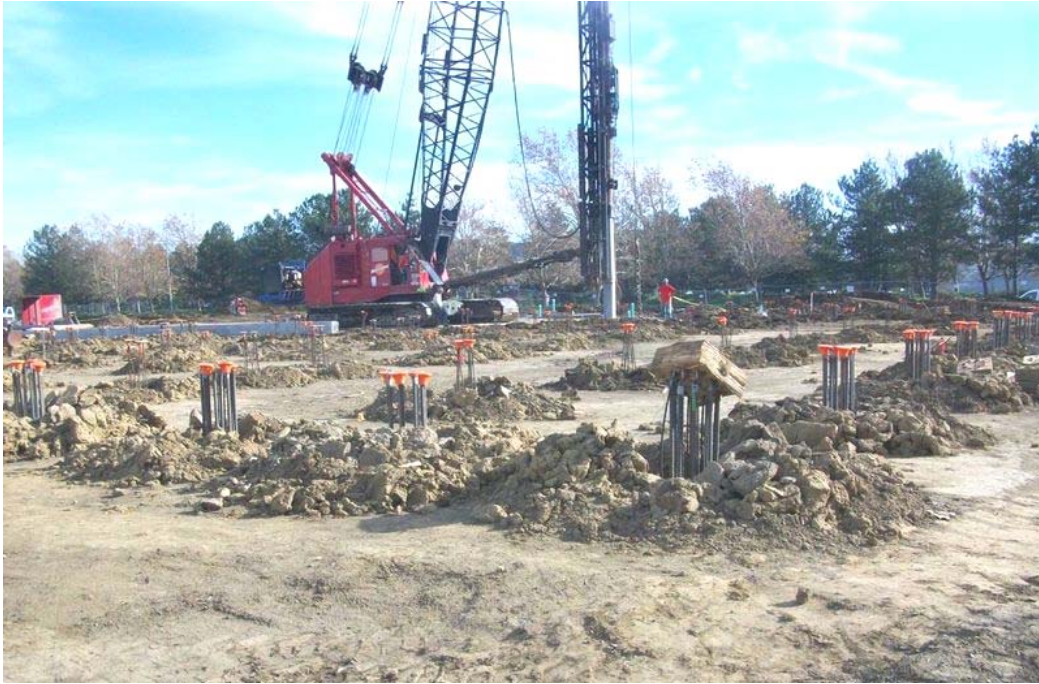
Слика 62. Изработка на колови за подобрување на тло Figure 62. Making of piles for improve soil
