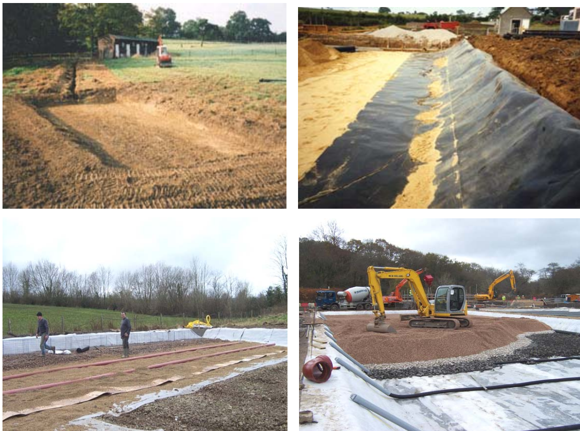
Слика 46. Градежни активности Figure 46. Construction activities
