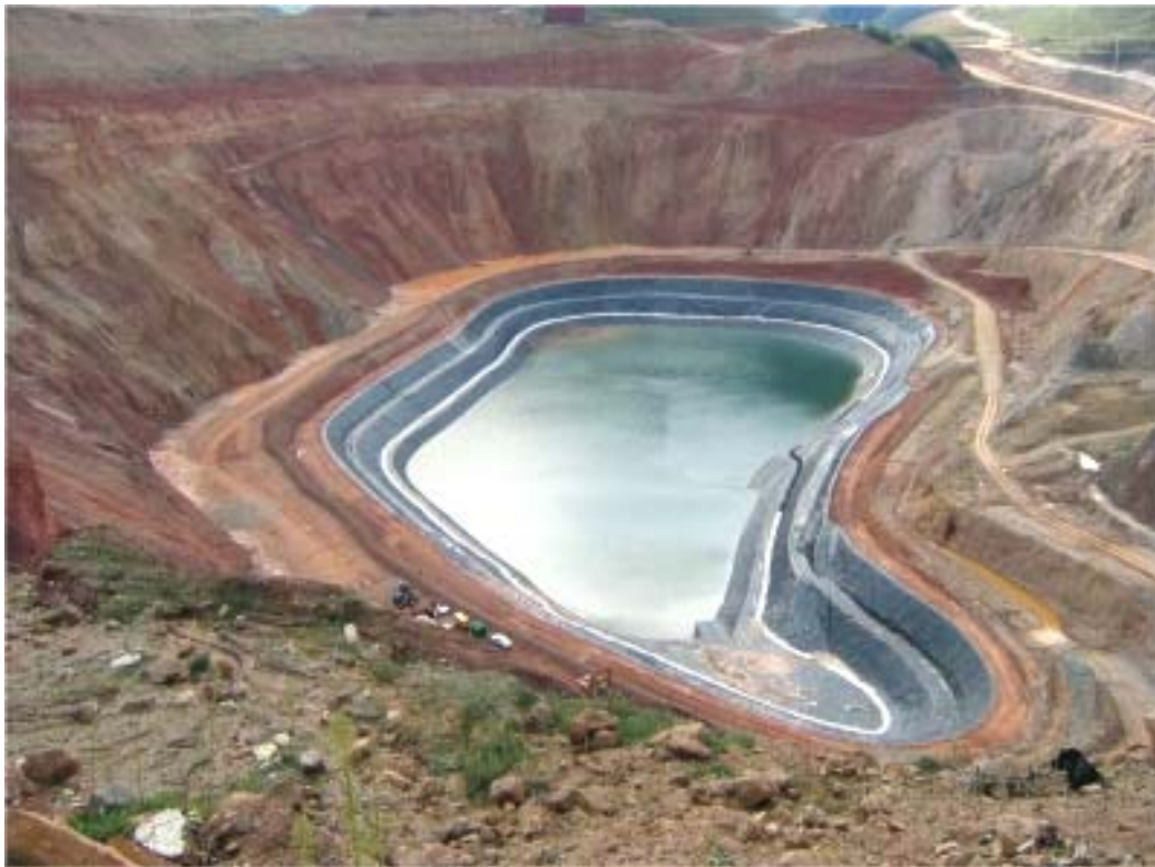
Слика 63. Флотациско јаловиште El Valle - Астуриас Figure 63. El Valle tailing disposal - Asturias
