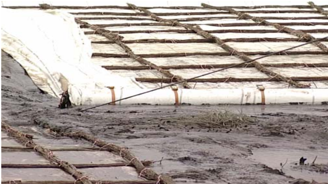
Слика 59. Поставување високојакосен геотекстил со плетена мрежа Figure 59. Setting of geotextiles with high strength and with geogrid
