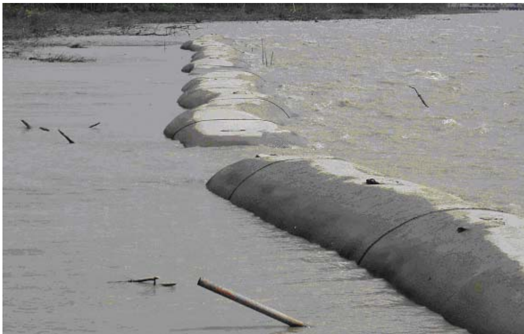
Слика 41. Инженерство со геотуби
