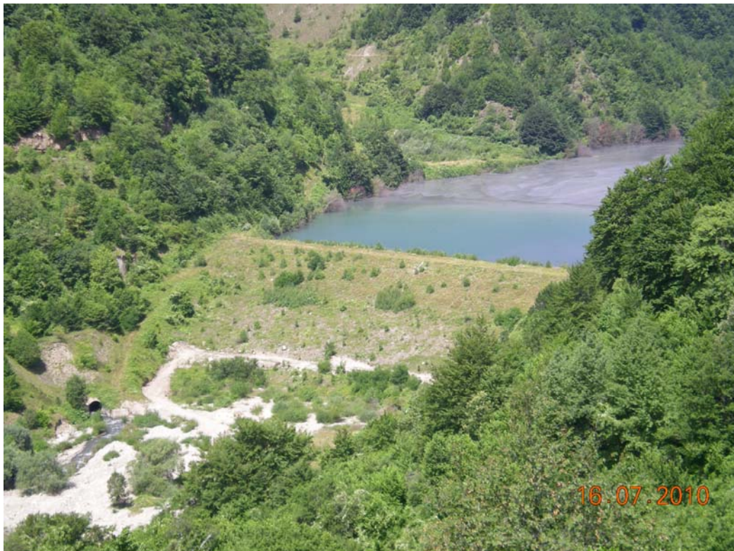
Слика 84. Ретензиона брана на хидројаловиштето Тораница Figure 84. Retention dam of Toranica tailing dump
