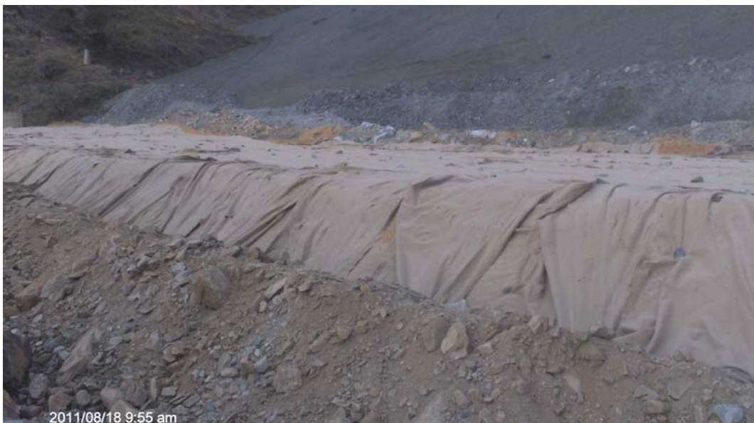
Слика 70. Дренажен килим на хидројаловиштето Саса Figure 70. Drainage carpet of Sasa tailing dump
