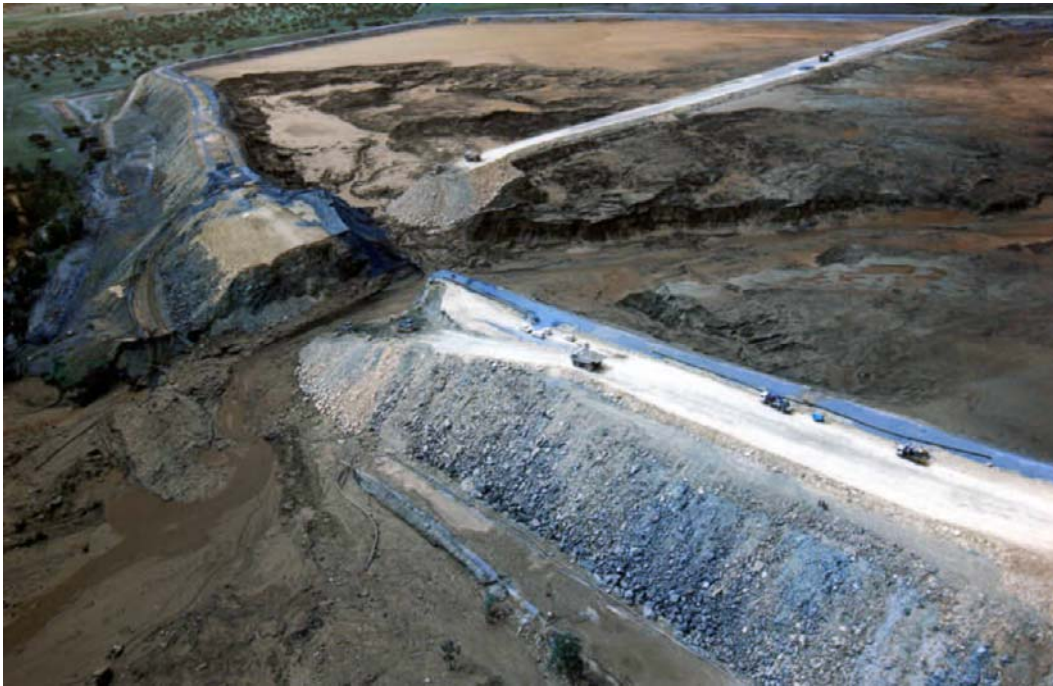
Слика 17. Хаварија на јаловиште Figure 17. Incident of tailing dump
