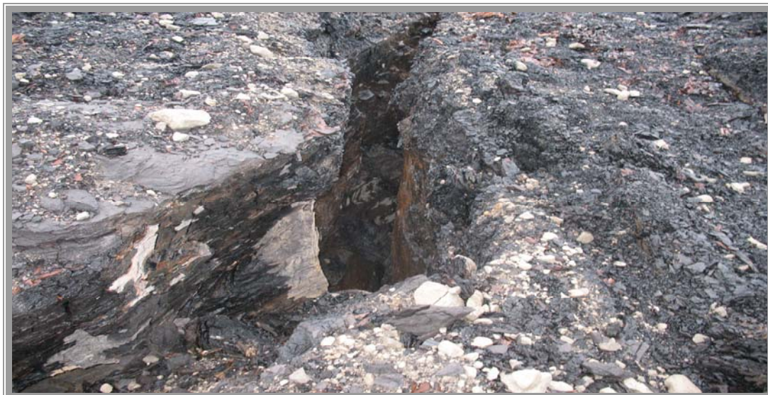
Слика 29. Кливажна пукнатина во јагленовиот слој Figure 29. Crack in the coal coating layer
