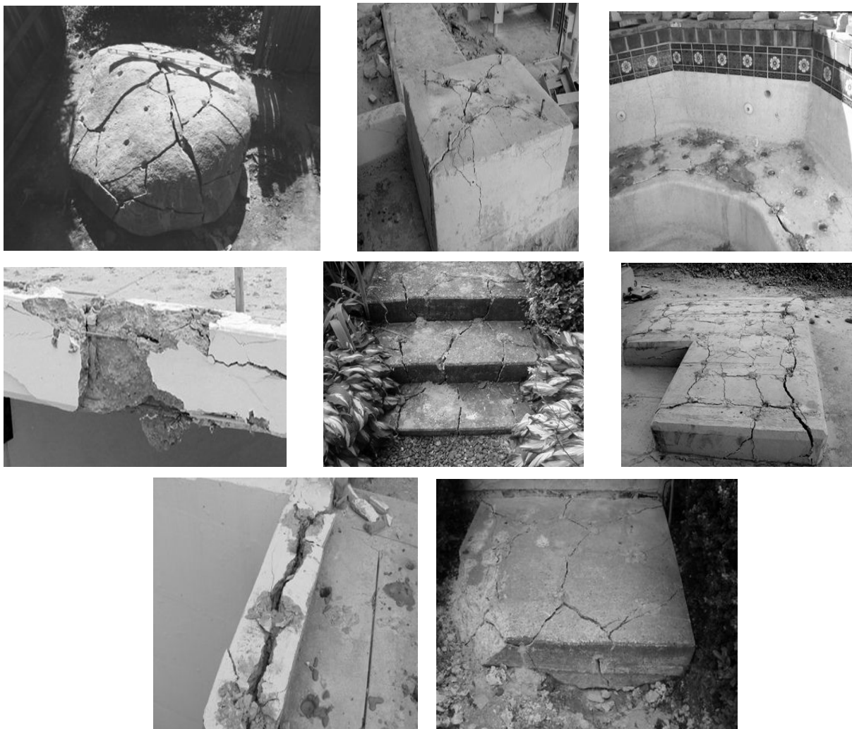
Сл. 19 Ефекти од примена на НЕРС - от за демолирање на различни АБ елементи
