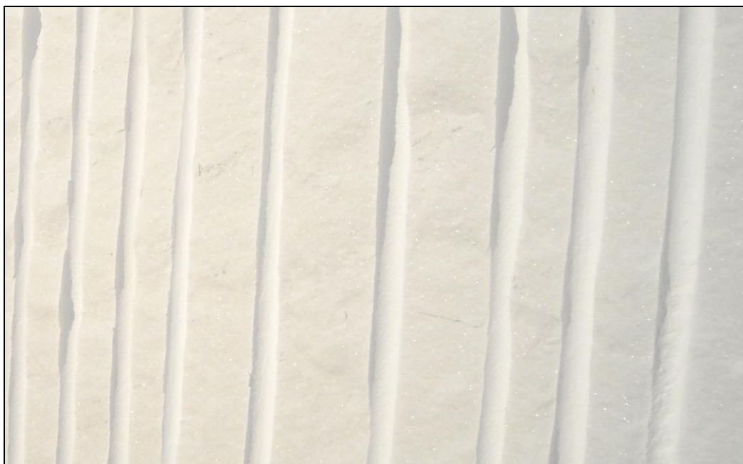
Слика 13. Доломитски мермер, од VI етажа во Работилиште бр.5 со снежнобела боја при свеж откршок, бидејќи мермерната маса е дупчена со пневматски дупчачки бургии, јасно се гледаат направените издупчувања во мермерот
