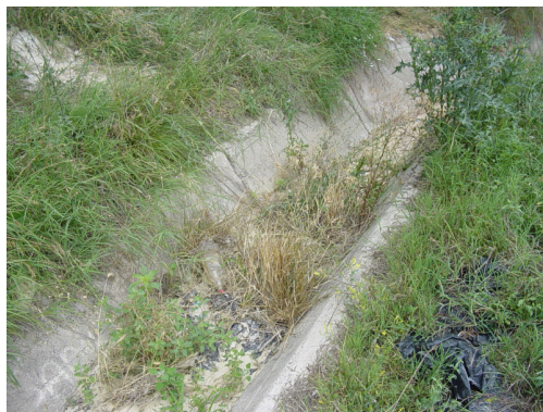
Слика 28. Постоечки бетонски канал
