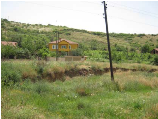
Слика 1. – Челна денивелациона пукнатина на свлечиштето во месноста Суитлак
