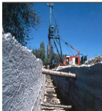
Slika 6. Rov ispunjen bentonitskom emulzijom
