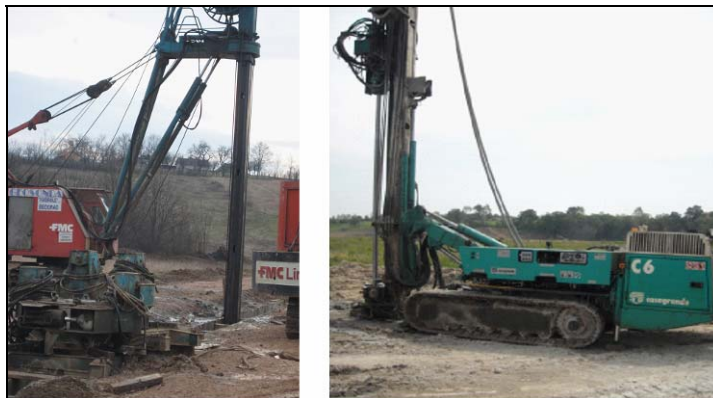
Slika 10. Oprema za mlazno injektiranje
