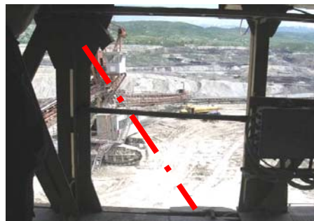
Slika 4. Nedostajući štap u konstrukciji
