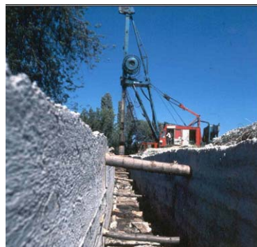
Slika 5. Uvodni kanal i grajfer za izradu ekrana
