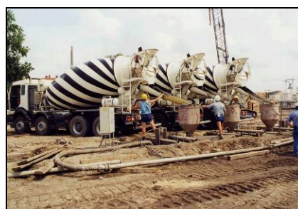
Slika 8. Ugradnja zapune u usek
