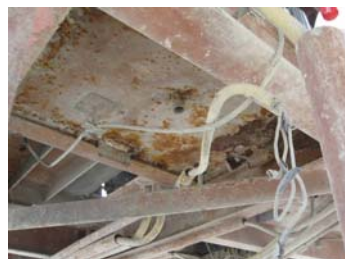
Slika 7. Degradacija antikorozivne zaštite
