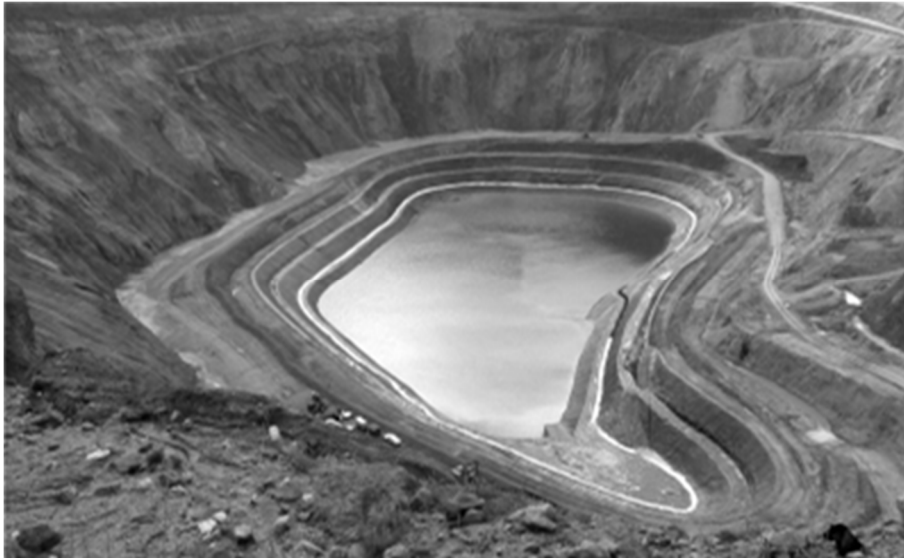
Слика 1. Хидројаловиште на рудникот Ел Валје - Астуријас, Шпанија
