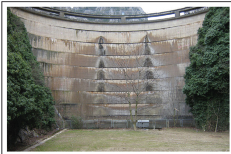
Санација на пукнатини, инјектирање и хидрозаштита на објект ХЕЦ Матка
