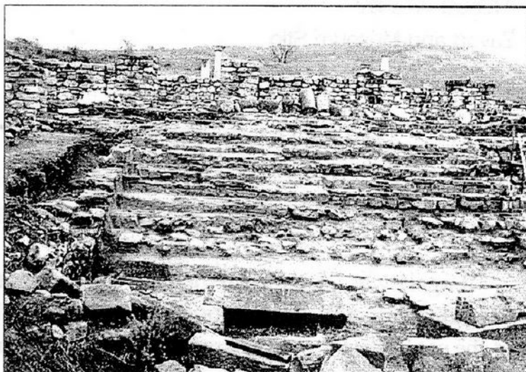
Сл. 14. Состојба на влезната партија по извршените конзерваторско-реставраторски работи
