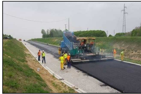
Слика 64: Вградување на асфалтна мешавина
