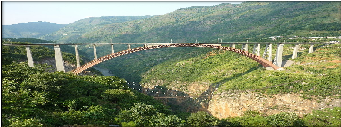
Слика 102: Мост со најголем распон од масивна градба – Железнички мост на реката Weiranjiang-China со должина на распон од 445 метри
