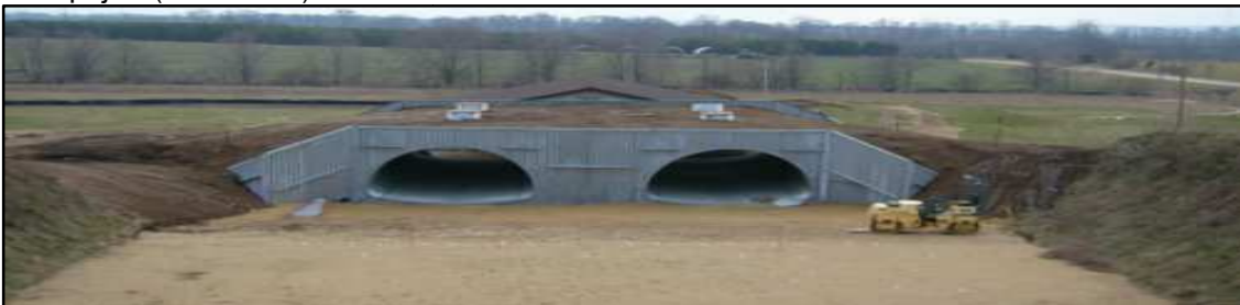
Слика 142: Параболични пропусти за цевки делумно исполнети со вода
