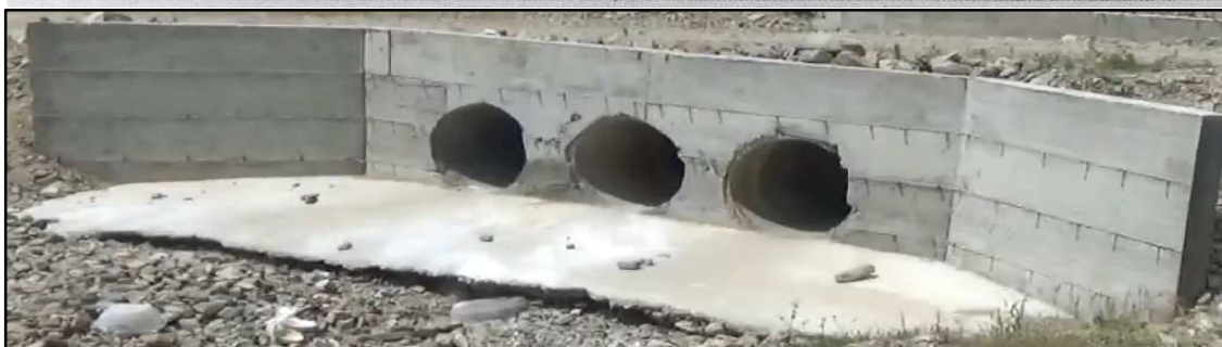
Слика 148: Пропуст од монтажни АБ цевки цевчест пропуст со два и три отвори
