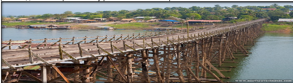
Слика 99: Saphan Mon Bridge – Thailand (400m)
