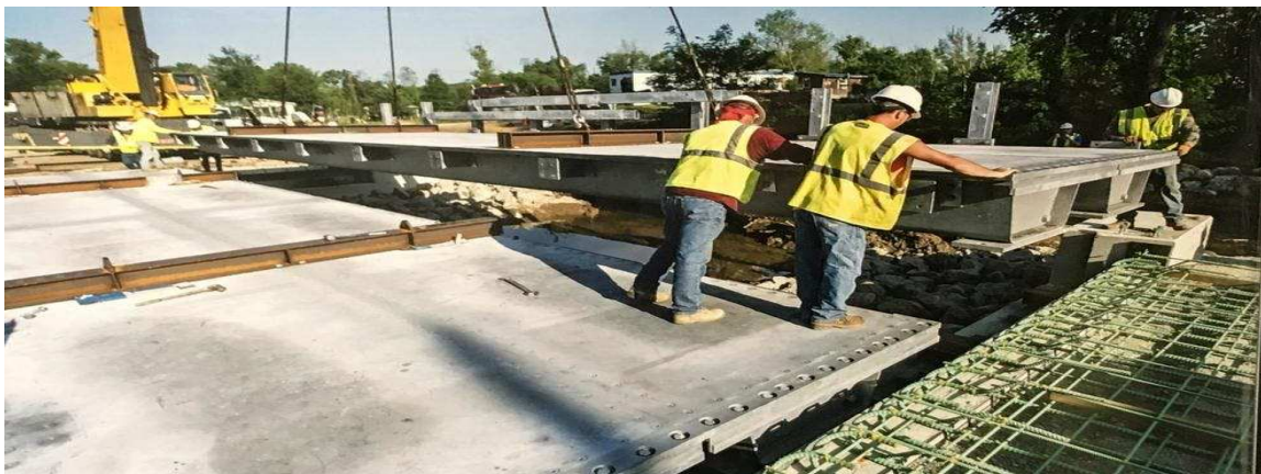
Слика 130: Бетонирање на главните носачи, напречните носачи
