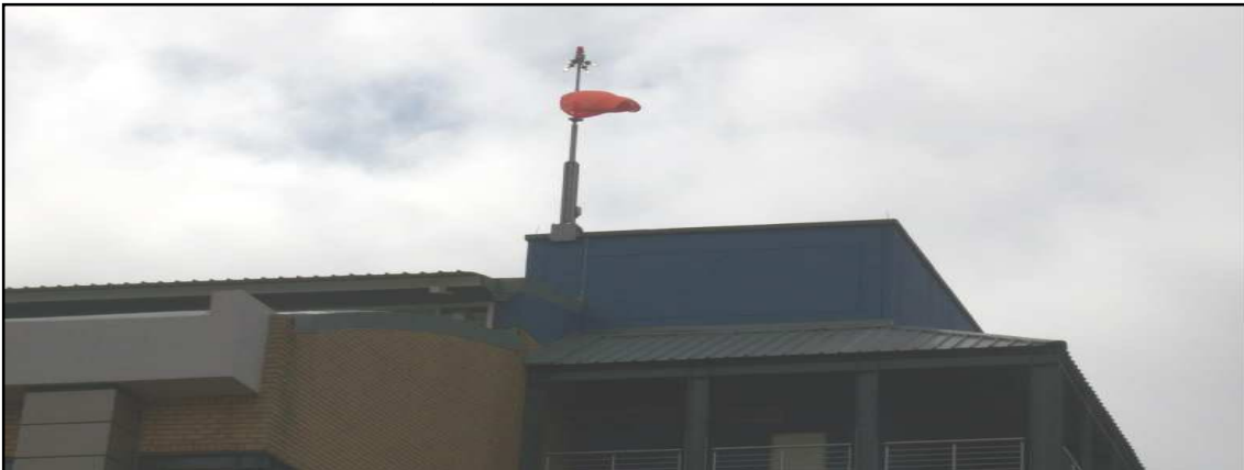
Слика 20: Индикатор за правец на ветер на врв на зграда односно покрив
