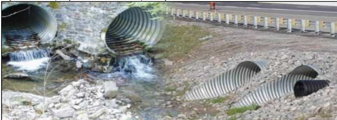
Слика 137: Пропуст со брановидни лимови
