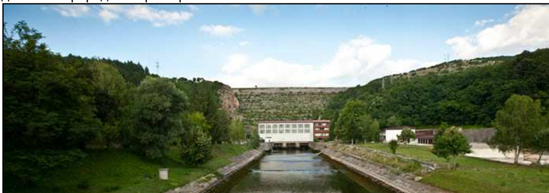
Слика 168: Хидроелектрана Шпилје
