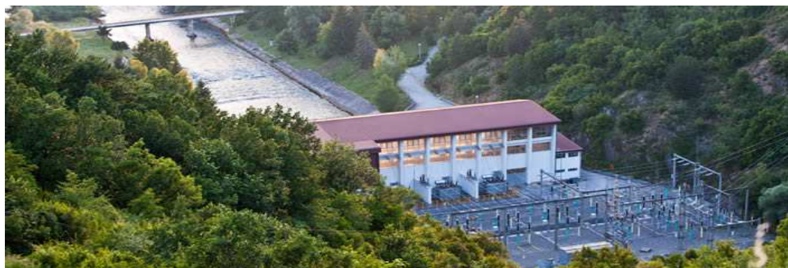
Слика 169: Хидроелектрана Шпилје
