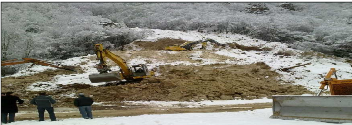
Слика 70: Изработка на девијација после појавата на лавина на пат Р-409 Маєрово-Дебар 2010 година
