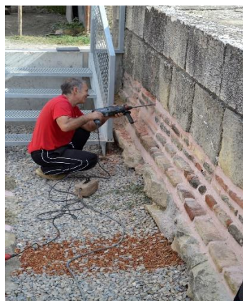
Сл.11 Отстранување на фугите од јужниот ѕид на кладенецот
