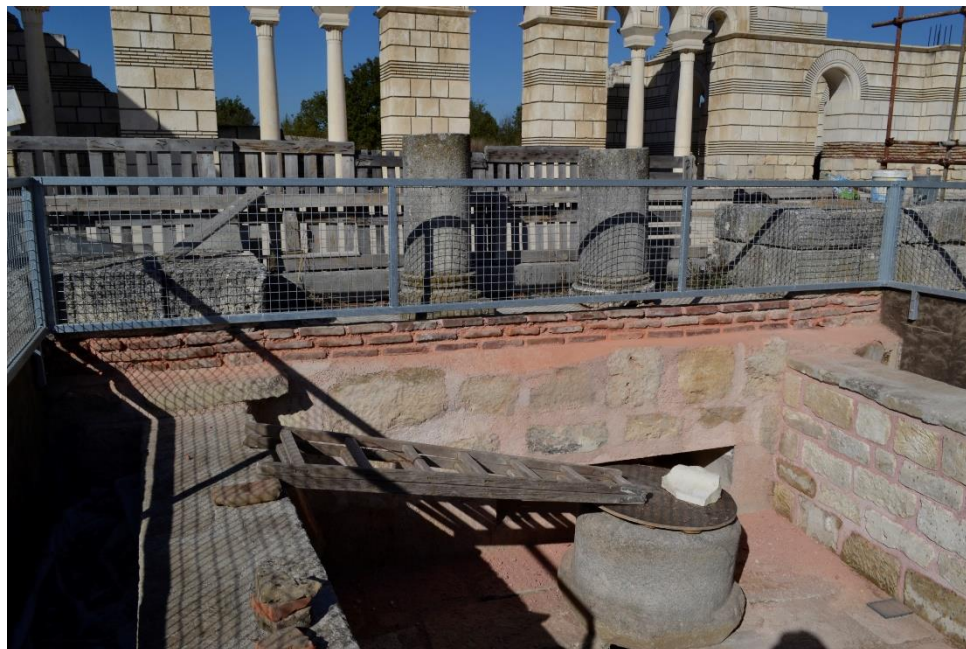
Сл. 11 – А, Северен ѕид на светиот кладенец по отстранувањето на розевите фуги
