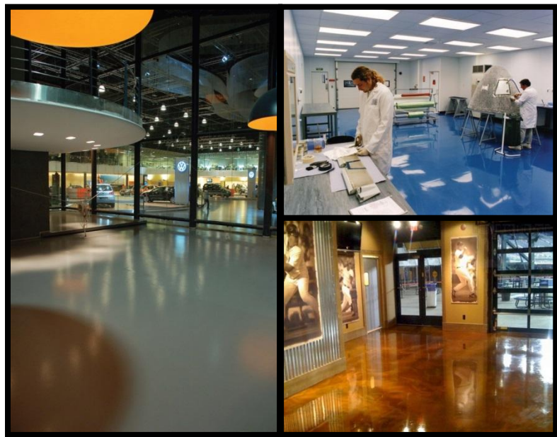
Сл.56. Подови од епоксидна смола Fig.56. Epoxy flooring
