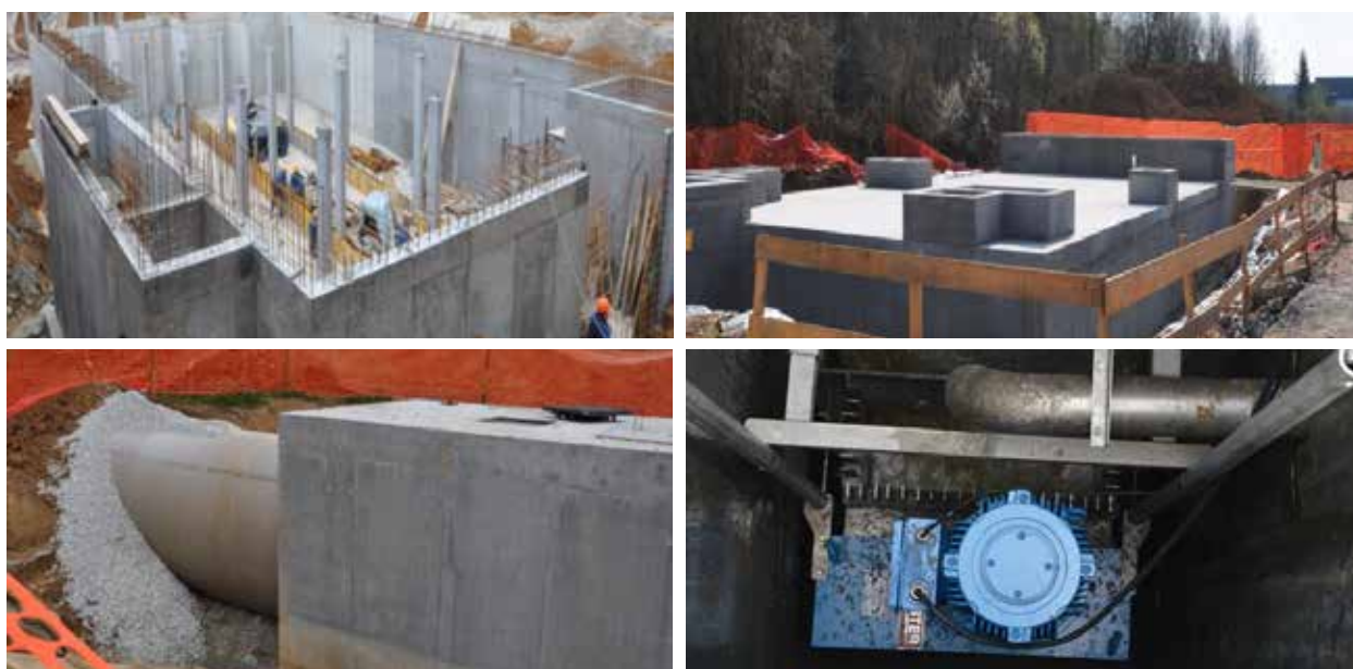
Слика 2: Структури за задржување вода на «С-каналот” за време на изградбата и инсталираниот механизам за мелење.
