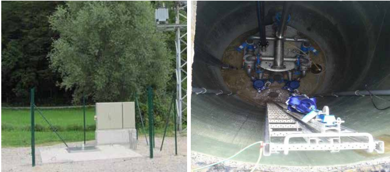
Слика 3: Сува пумпна станица Мали Врх
