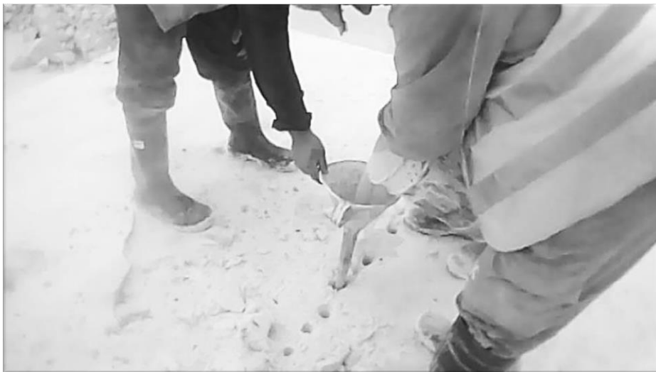
Слика 6. Ставање на експандирачка смеса во дупкотини
