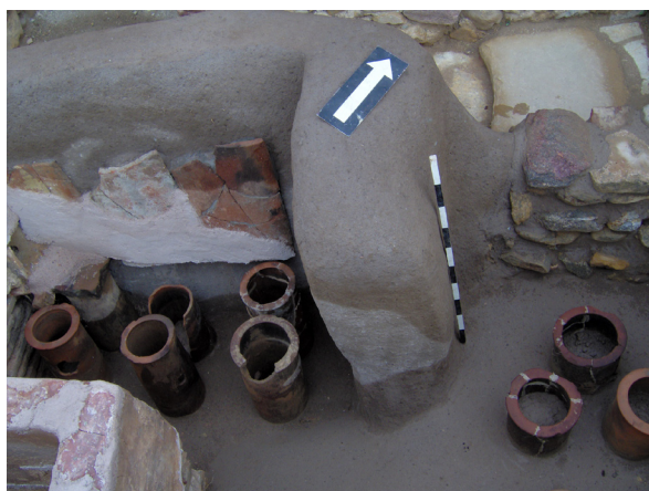
Ил. 3 - Внатрешната фасада на северозападниот ѕид и хипокаустични стилоци по конзерваторско-реставраторските работи.
