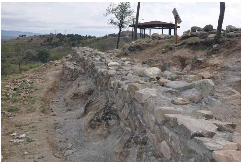
Сл.11. Затварање на горната површина на бедемот
