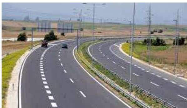
Слика 4. Автомат/Picture 4 Highway
